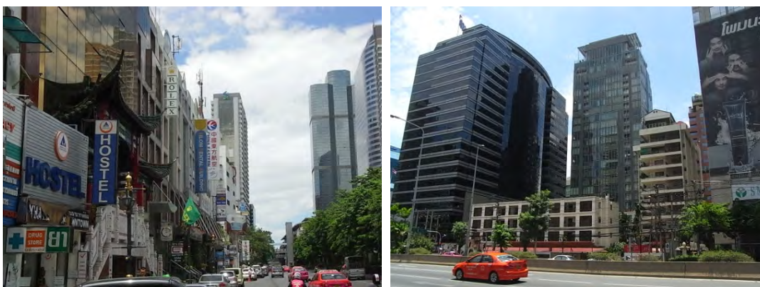
ภาพที่ 5.14 สภาพพื้นที่ตัวอย่างบริเวณกลุ่มอาคารสูงย่านถนนสุขวงศ์ สีลม สาทร และนราธิวาส ราชนครินทร์
