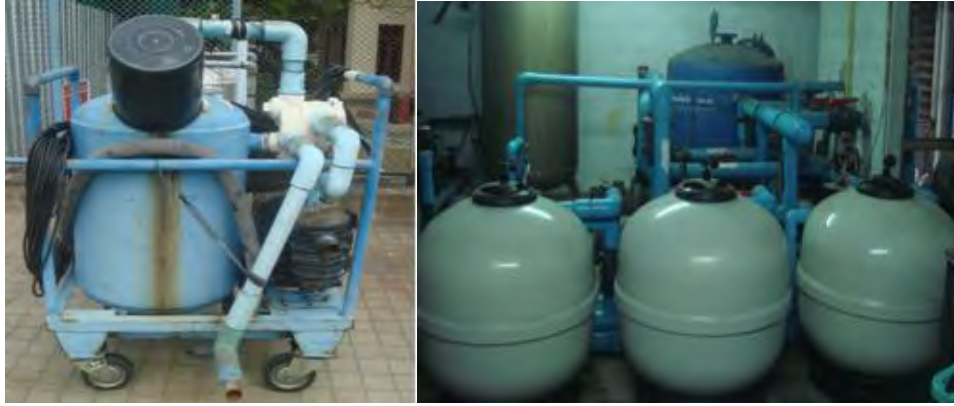
ภาพที่ 3.8 เครื่องดูดตะกอน และถังกรองทราย (sand filter)
