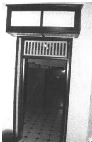
ภาพที่ 53 ลักษณะประตูภายในตึกแถว ซึ่งเป็นประตูไม้บานเปิดคู่ ขนาด 1.20 x 2.40 ม.
