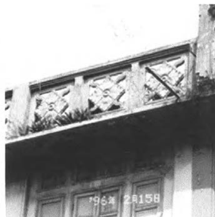
ภาพที่ 148 การเสื่อมสภาพของวัสดุที่เกิดจากความเก่าแก่ และปัญหาจากเขม่าควันรถยนต์ ริมถนน
