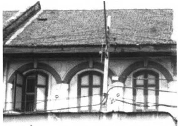
ภาพที่ 40 วัสดุผนังหลังคาเดิมเป็นกระเบื้องดินเผา
