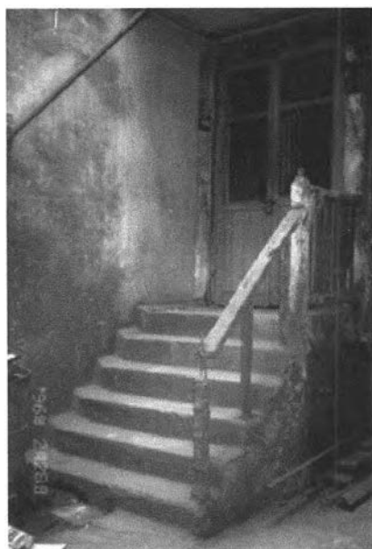
ภาพที่ 142 ลักษณะบันไดภายนอกและภายในของตึกแถวริมถนนเจริญกรุง ตัดกับถนนข้าวหลาม - ถนนทรงวาด
