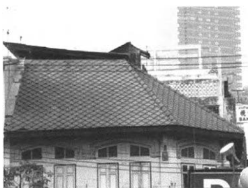
ภาพที่ 125 หลังคาโครงสร้างไม้มุงด้วยกระเบื้องหางว่าวของตึกแถวริมถนนเจริญกรุง เขตบางรัก
