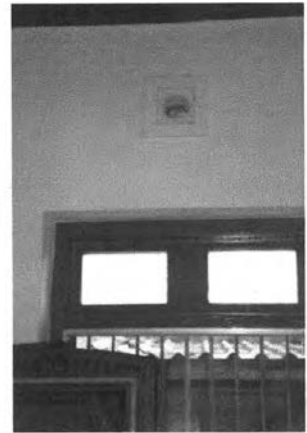
ภาพที่ 111 ลักษณะช่องลมและช่องแสงเหนือหน้าต่างของตึกแถวริมถนนเจริญกรุง ตรอกวัดม่วงแค
