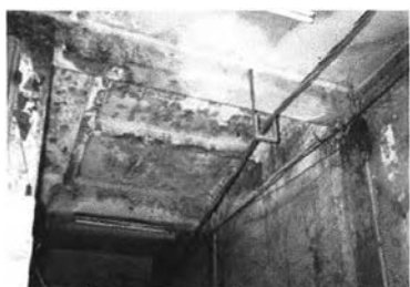
ภาพที่ 147 การเสื่อมสภาพของวัสดุที่เกิดจากปัญหาความชื้น ที่เกิดจากระบายน้ำฝนของหลังคาไม่ดี
