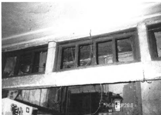
ภาพที่ 148 การเสื่อมสภาพของวัสดุที่เกิดจากความเก่าแก่ และปัญหาจากเขม่าควันรถยนต์ ริมถนน
