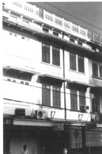
ภาพที่ 158 ผนังก่ออิฐฉาบปูนทาสี ซึ่งสีเดิมเป็นสีเหลืองและสีน้ำปูน
