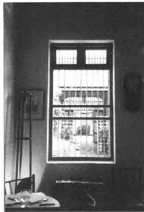
ภาพที่ 111 ลักษณะช่องลมและช่องแสงเหนือหน้าต่างของตึกแถวริมถนนเจริญกรุง ตรอกวัดม่วงแค
