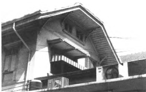
ภาพที่ 67 ปัญหาเรื่องระบบวิศวกรรมและการต่อเติมกันสาดที่มีผลต่อรูปด้านภายนอกตึกแถว
