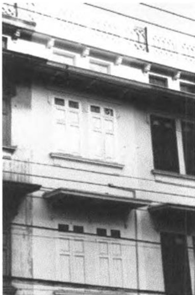
ภาพที่ 154 ลักษณะหน้าต่างบานเปิดคู่และช่องลมช่องแสงของตึกแถวริมถนนเจริญกรุง ซอย 43
