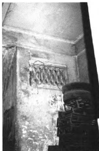
ภาพที่ 147 การเสื่อมสภาพของวัสดุที่เกิดจากปัญหาความชื้น ที่เกิดจากระบายน้ำฝนของหลังคาไม่ดี
