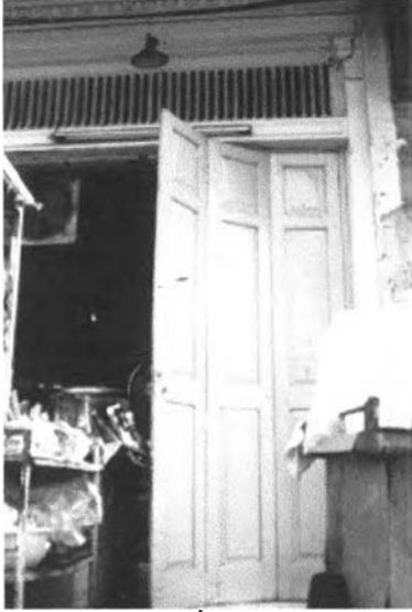
ภาพที่ 153 ลักษณะประตูบานเฟี้ยมไม้ด้านหน้าของตึกแถวริมถนนเจริญกรุง ซอย 43
