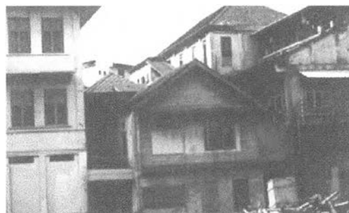
ภาพที่ 89 การต่อเติมตึกแถวริมถนนเจริญกรุง ซอย 35 ที่มีผลต่อภูมิทัศน์ของย่าน
