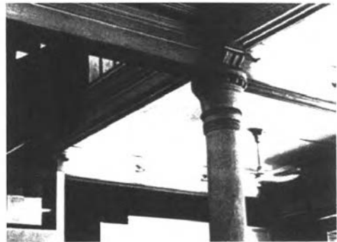
ภาพที่ 57 โครงสร้างระบบเสาและคานของตึกแถวริมถนนเจริญกรุงตัดกับถนนจักรวรรดิ - ถนนราชจักร
