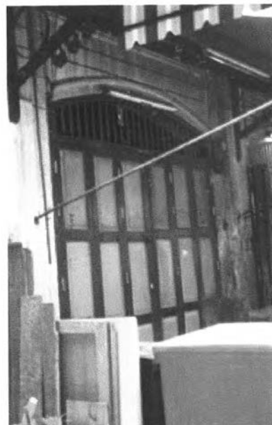
ภาพที่ 132 การเสื่อมสภาพของส่วนประกอบทางสถาปัตยกรรม ที่เกิดจากกาลเวลาและฝุ่นควันรถยนต์
