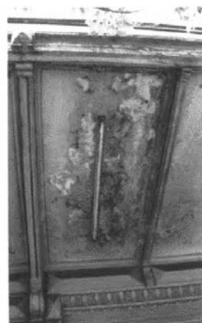
ภาพที่ 63 ผนังปูนฉาบและฉาบเพดานภายนอกเสื่อมสภาพ เนื่องจากปัญหาเรื่องความชื้น
