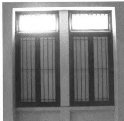
ภาพที่ 54 ลักษณะช่องแสงและหน้าต่างไม้บานเปิดคู่ มีทั้งที่เป็นลูกฟักไม้กระดานดุนและลูกฟักบานเกล็ดไม้
