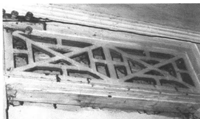
ภาพที่ 81 ลักษณะช่องลมเหนือหน้าต่างของตึกแถวริมถนนเจริญกรุง ซอย 35 เชียงสะพานพิทยเสถียร
