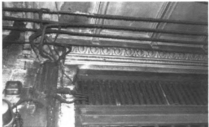
ภาพที่ 161 ปัญหาทางสถาปัตยกรรมที่เกิดจากความเก่าแก่ของตึกแถว และเขม่าควันจากรถยนต์
