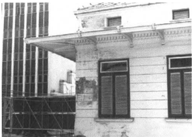
ภาพที่ 63 ผนังปูนฉาบและฉาบเพดานภายนอกเสื่อมสภาพ เนื่องจากปัญหาเรื่องความชื้น
