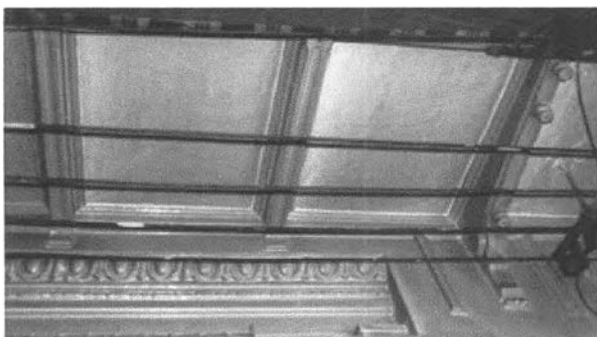
ภาพที่ 157 ลักษณะฝ้าเพดาน ค.ส.ล. ภายนอก และฝ้าเพดานไม้ภายในตึกแถวริมถนนเจริญกรุง ซอย 43
