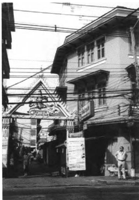
ภาพที่ 116 ตึกแถวสามชั้นริมถนนเจริญกรุง ตรอกวัดม่วงแค ที่มีการปรับปรุงเปลี่ยนแปลงจนทำให้มีผลกระทบต่อนักท่องเที่ยวของบริเวณ
