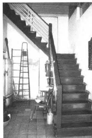
ภาพที่ 38 ลักษณะบันไดไม้ของชุดตึกแถวริมถนนเจริญกรุงตอนใน เชียงสะพานมอญจนถึงสี่แยกสามยอด
