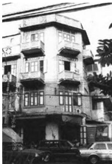
ภาพที่ 137 ผนังด้านหน้าเป็นผนังก่ออิฐฉาบปูน ทาสี ของชุดตึกแถวริมถนนเจริญกรุง ติดกับถนนข้าวหลาม - ถนนทรงวาด
