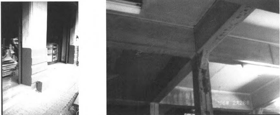
ภาพที่ 144 โครงสร้างหลักที่เป็นเสาและคาน ค.ส.ล. ของตึกแถวริมถนนเจริญกรุง ตัดกับถนนข้าวทกลม - ถนนทรงวาด
