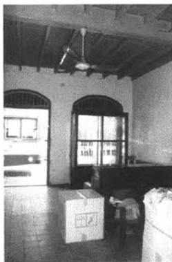
ภาพที่ 37 ช่องแสงและช่องลมของชุดตึกแถวริมถนนเจริญกรุงตอนใน เชียงสะพานมอญจนถึงสี่แยกสามยอด
