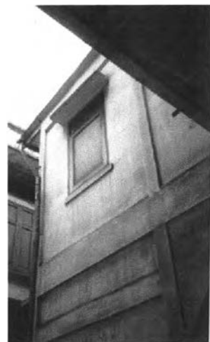
ภาพที่ 147 การเสื่อมสภาพของวัสดุที่เกิดจากปัญหาความชื้น ที่เกิดจากระบายน้ำฝนของหลังคาไม่ดี
