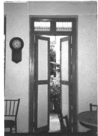
ภาพที่ 108 ลักษณะประตูไม้บานเปิดคู่ ลูกฟักกระดานดุนของตึกแถวริมถนนเจริญกรุง ตรอกวัดม่วงแค
