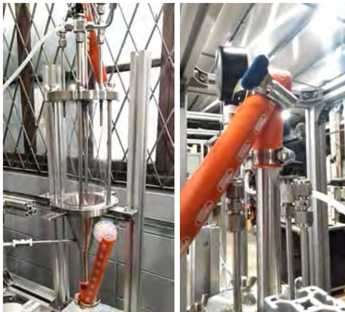
รูปที่ 24 แสดงการดำเนินการตรวจสอบท่อพื้นฟูสภาพ
