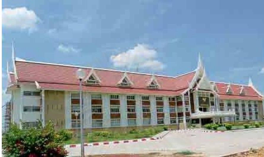
ภาพที่ 4.1 ศาลากลางจังหวัดหลังใหม่จังหวัดนนทบุรี
