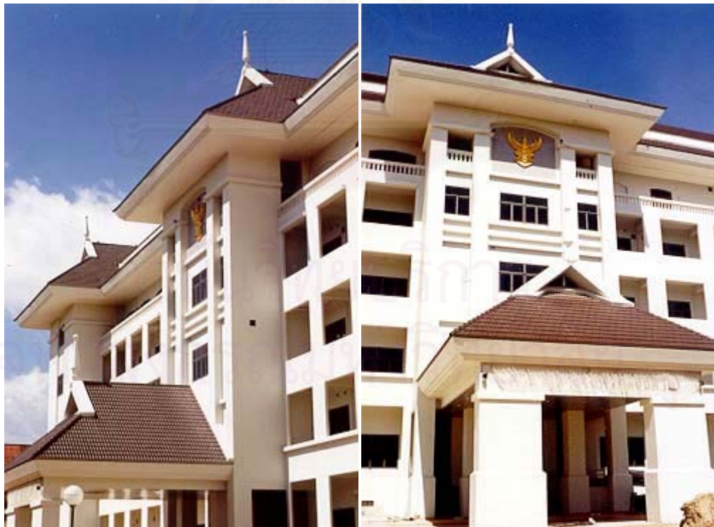
ภาพที่ 4.2, 4.3 มุขกลางและหลังคาแบบพื้นถิ่นของอาคารศาลากลางจังหวัดหลังใหม่ จังหวัดสงขลา
