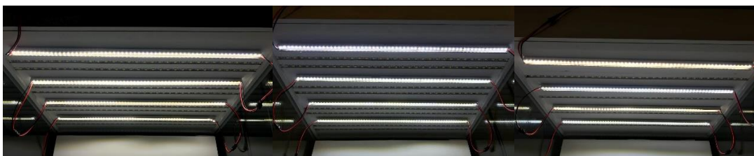
ภาพที่ 3.7 ไฟ LED strip light ที่ใช้ในการติดตั้งด้านบนในตู้โชว์ อุณหภูมิสีของแสง 4000K 6000K และแสงผสมระหว่าง 4000K และ 6000K
