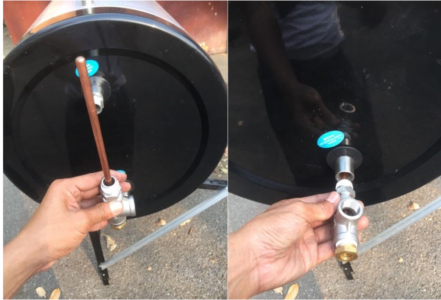
รูปที่ 3.8 ท่อทองแดงปลายปิดสำหรับใส่เซนเซอร์ เพื่อวัดค่าอุณหภูมิน้ำภายในถังเก็บน้ำร้อน
