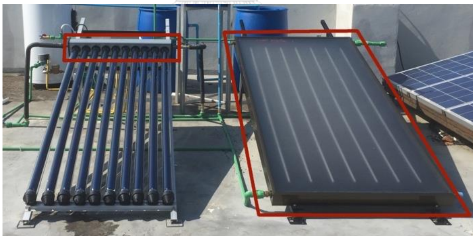
รูปที่ 4.12 ส่วนที่มีการสูญเสียความร้อนของแผงทำความร้อนทั้งสองชนิด
