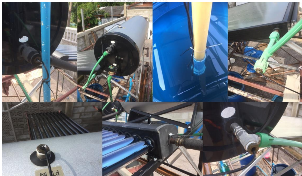
รูปที่ 3.9 ติดตั้งเซนเซอร์ตามจุดที่กำหนด
