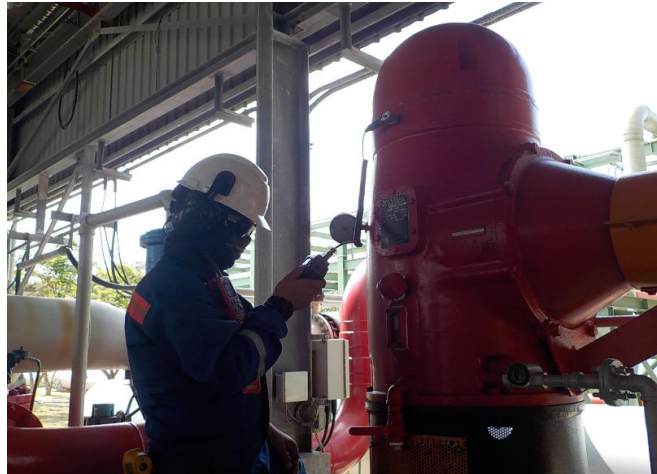
รูปที่ 5.12 วิธีวัดการสั่นสะเทือนของเครื่องสูบลมและชุดเกียร์
