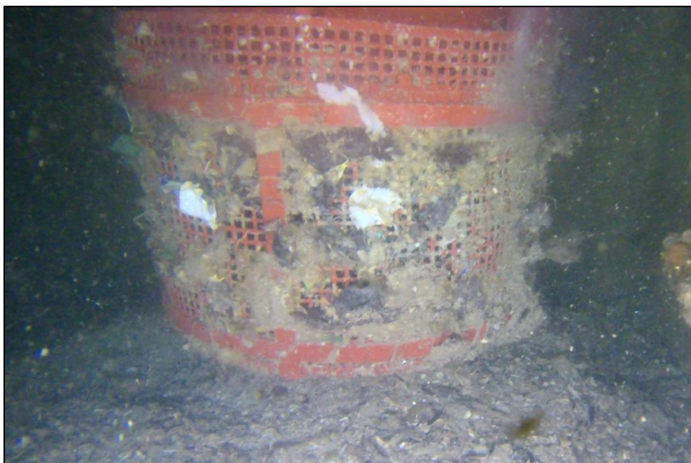
รูปที่ 6.8 ผลการตรวจสอบพบความผิดปกติจากกรองเครื่องสูบน้ำเริ่มต้น
