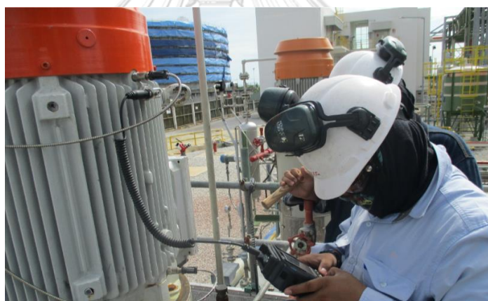
รูปที่ 5.1 วิธีการตรวจวัดค่าการสั่นสะเทือนของมอเตอร์ไฟฟ้า
