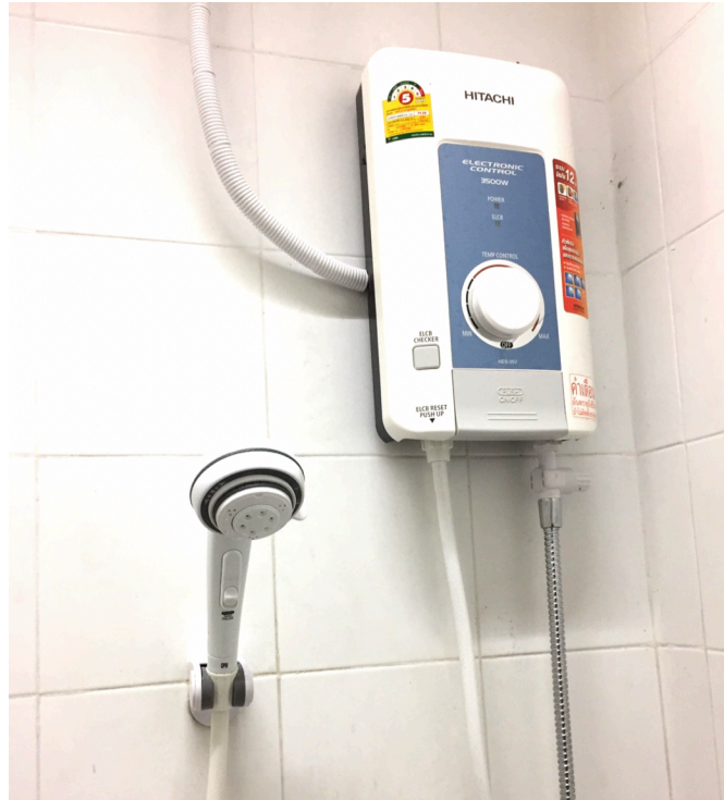
รูปที่ 6.22: เครื่องทำน้ำอุ่นได้ถูกติดตั้งในห้องอาบน้ำอาคารปฏิบัติการ ESID
