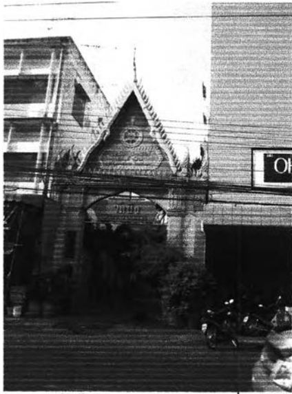
ภาพ 1.1 วัดบึงลักษณะสถาปัตยกรรม ที่ถูกบดบังจากกลุ่มอาคาร
