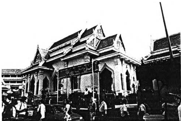
ภาพที่ 3.36 พระอุโบสถวัดไตรมิตรวิทยาราม ออกแบบโดยลตทอนรายละเอียด และให้มีรูปแบบที่เหมาะสมกับอาคารคอนกรีตเสริมเหล็กมากขึ้น
