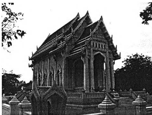
ภาพที่ 3.38 พระอุโบสถวัดชลประทานรังสฤษฎ์ ซึ่งรูปแบบอาคารเป็นแบบลตทอนรายละเอียดเช่นกัน ให้ความรู้สึกหนักแน่น เหมาะสมกับวัสดุก่อสร้างซึ่งใช้คอนกรีตเสริมเหล็ก
