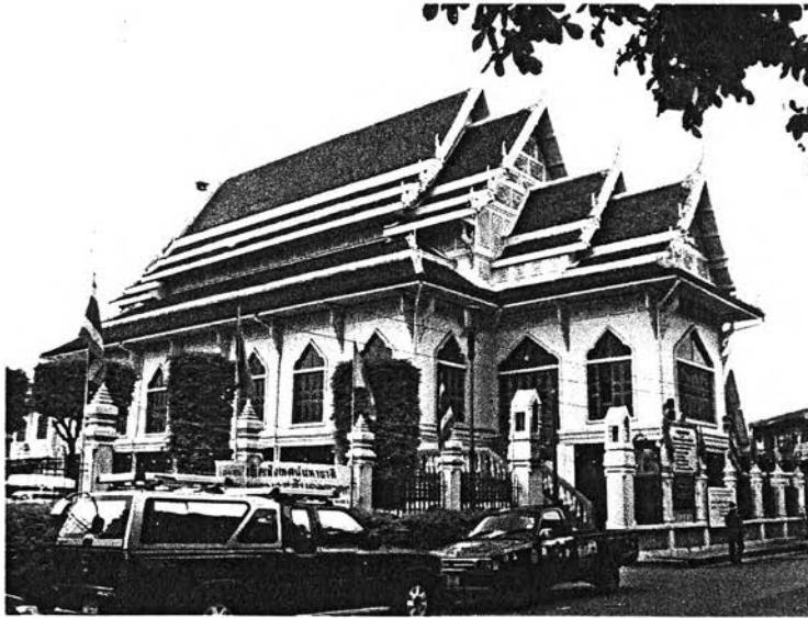
ภาพที่ 3.24 ศาลาการเปรียญ วัดอินทรวิหาร ซึ่งมีรูปแบบคล้ายกับศาลาการเปรียญ วัดราชาธิวาส แต่เป็นการเปลี่ยนจากอาคารโครงสร้างไม้ มาเป็นอาคารคอนกรีตเสริมเหล็ก
