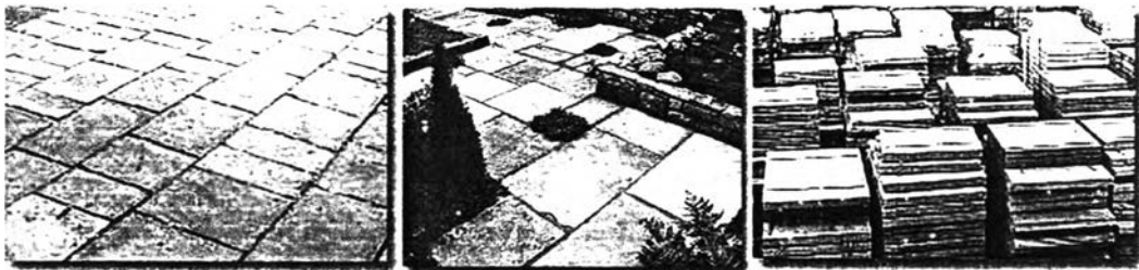
รูปที่ 2.2 แสดงตัวอย่างบล็อกประสานปูพื้นประเภทหินธรรมชาติ
