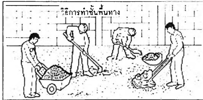
ใส่ชั้นโดยใส่ทีละชั้นในดินเดิม โดยเทจากกระบะรถเข็นเป็นวิธีที่ง่ายที่สุดและประหยัดวัสดุ โดยหนาชั้นละ 5 - 10 ซม. จนได้ความหนาที่ต้องการ
