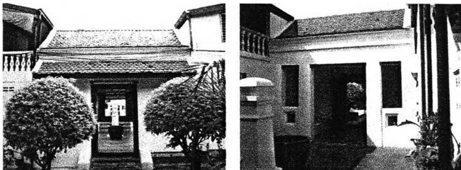
ภาพที่ 4.60 ซุ้มประตูหน้าคณะ 1 ด้านนอก และซุ้มประตูหน้าคณะ 1 ด้านใน
