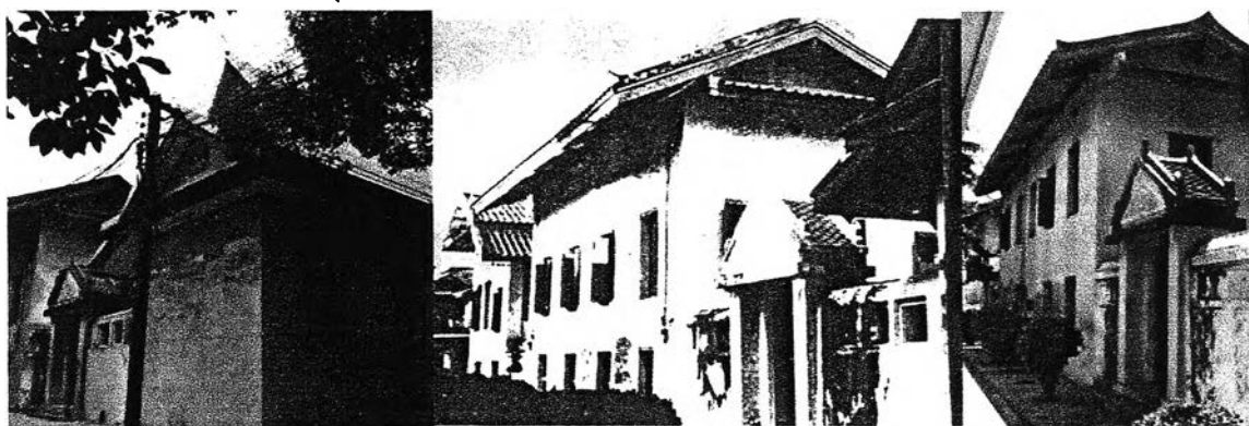
ภาพที่ 4.105 ภาพถ่ายเก่าแสดงซุ้มประตูทางเข้าหมู่กุฏิในอดีต และอาคารกุฏิบางหลัง สามารถใช้สันนิษฐานรูปแบบเดิมของอาคารได้
