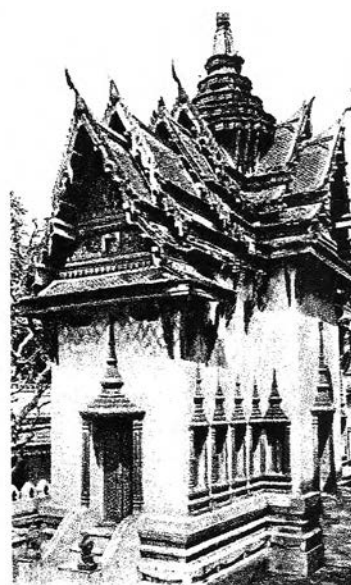
อาคารหอพระไตรปิฎกหลังเก่าที่ถูกรื้อลง
