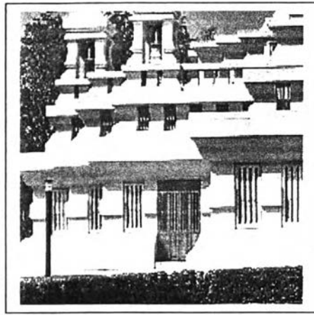
รูปที่ 3.5 แสดงลักษณะของช่องแสงเหนือระดับสกายตาและช่องแสงระดับสกายตา
