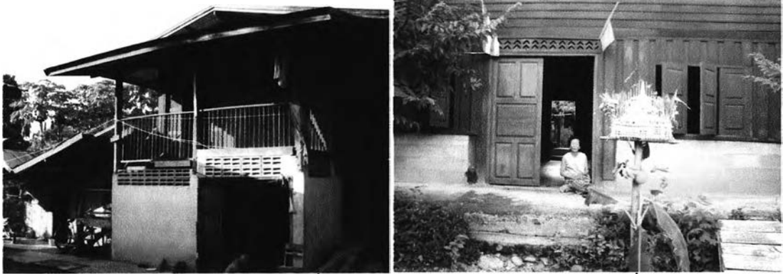
รูปที่ 5.21 การต่อเติมและเปลี่ยนแปลงบริเวณด้านล่างเรือนพักอาศัยแบบจั่วแฝด
