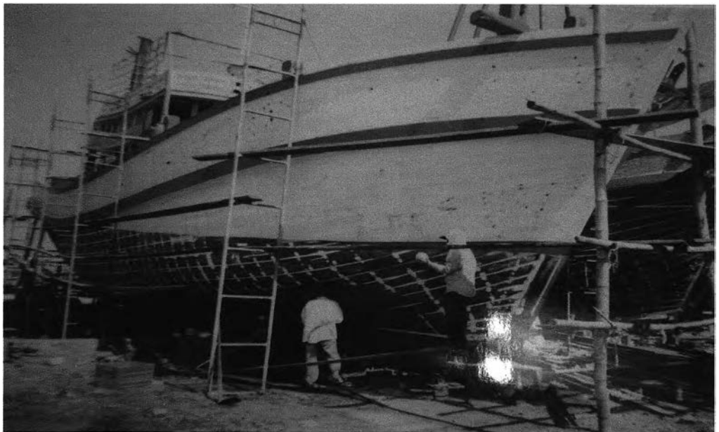
รูปที่ 1.3 เรือประมงที่ซ่อมแซมด้วยผลิตภัณฑ์ประกอบแต่งเรซินอีพ็อกซีเสร็จแล้วและกำลังตกแต่งด้วยสีเคลือบภายนอก
