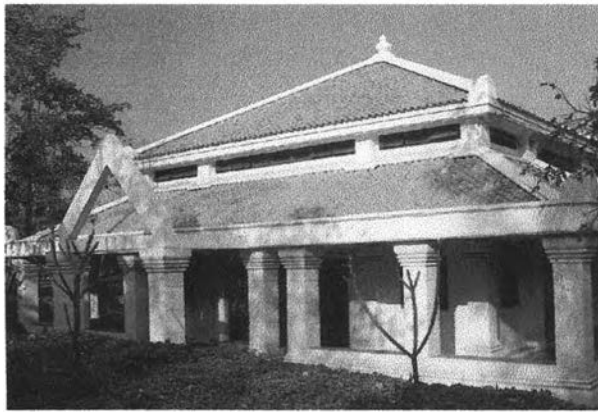
ภาพที่ 3.18 แสดงผนังที่เป็นอิฐก่อฉาบปูน และพ่นด้วยสีผสมเม็ดทรายทำให้เกิดผิวสัมผัส
