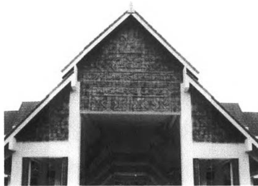
ภาพที่ 3.39 ภาพจริง อาคาร 25 ปี มหาวิทยาลัยขอนแก่น ขอนแก่น งานตกแต่งหน้าจั่วและหน้าอุด เป็นประติมากรรมดินเผา
