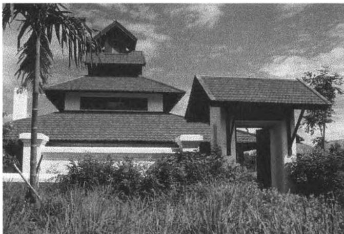
ภาพที่ 3.48 ภาพหลังการจำลองของ บ้านจิ้งน๊ก วัสดุมุงหลังคาคือ กระเบื้องโมเนีย
