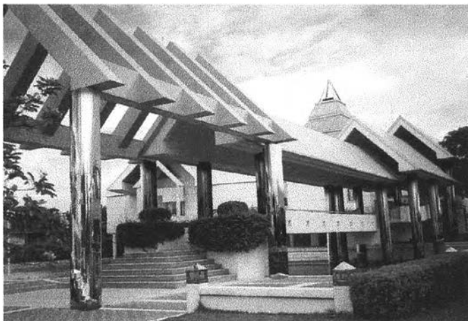
ภาพที่ 3.30 ภาพหลังการจำลองของศูนย์ศึกษาประวัติศาสตร์ อยุธยา เสาหุ้มสแตนเลส (วัสดุเทคโนโลยีขั้นสูง)
