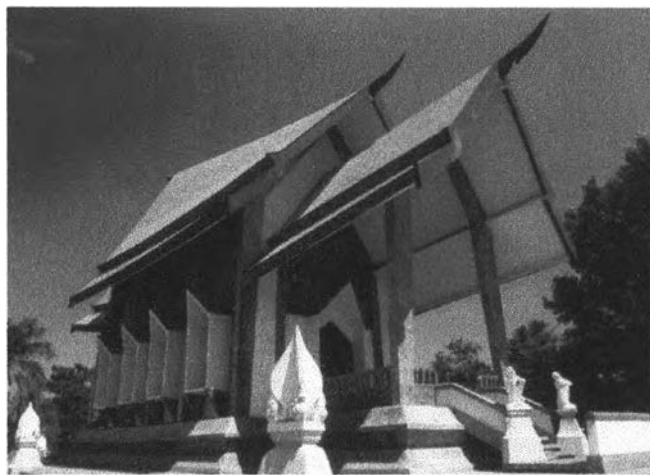
ภาพที่ 3.51 ภาพจริงของ อุโบสถวัดศาลาลอย ผิวหลังคา ค.ส.ล. มุงทับด้วยกระเบื้องดินเผา
