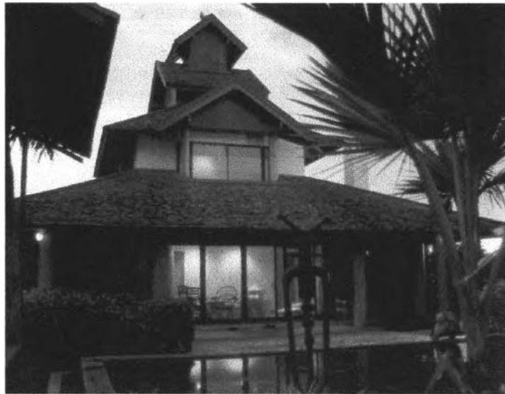
ภาพที่ 3.21 แสดงการใช้วัสดุแบบพื้นถิ่นทางเหนือเฉพาะหลังคา
