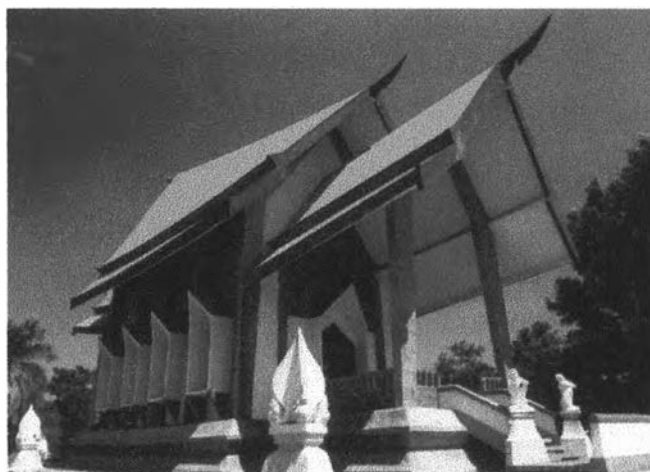
ภาพที่ 3.52 ภาพหลังการจำลองของ อุโบสถวัดศาลาลอย หลังคาผิวคอนกรีตฉาบเรียบ ทาสี
