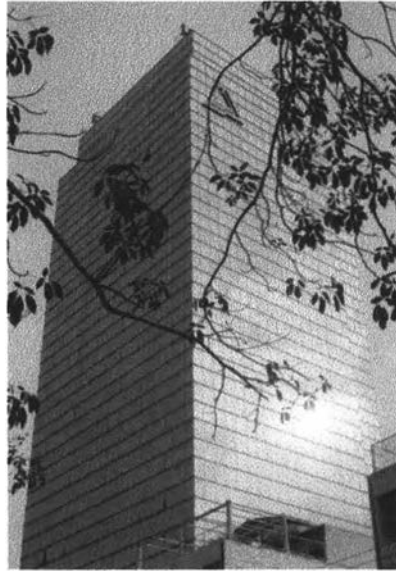
ภาพที่ 5.2ก1 ผืนกระจกสีทอง อาคารสำนักงานใหญ่ธนาคารแหลมทอง
