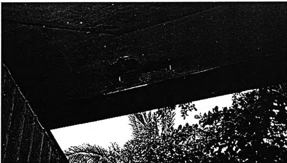
รูปที่ 5-10 ไฟฟ้าบริเวณบันไดขึ้นลงอาคารชำรุด
