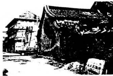
อาคารพาณิชย์บริเวณถนนนครนอก-นครใน
