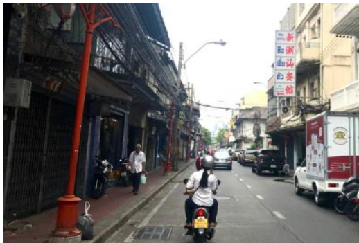
ภาพที่ 5- 17 ตัวอย่างลักษณะและความกว้างของทางเดินเท้าต่ำกว่าเกณฑ์มาตรฐาน ระดับที่ 1 สภาพทางเท้าของถนนทรงวาด (ฟุตบอลซ้าย) ซึ่งเป็นย่านพักอาศัยและแหล่งการค้าส่ง
