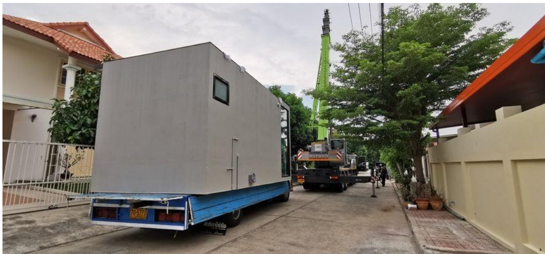
รูปที่ 11 การขนส่งอาคารโครงสร้างสำเร็จรูประบบกล่อง
