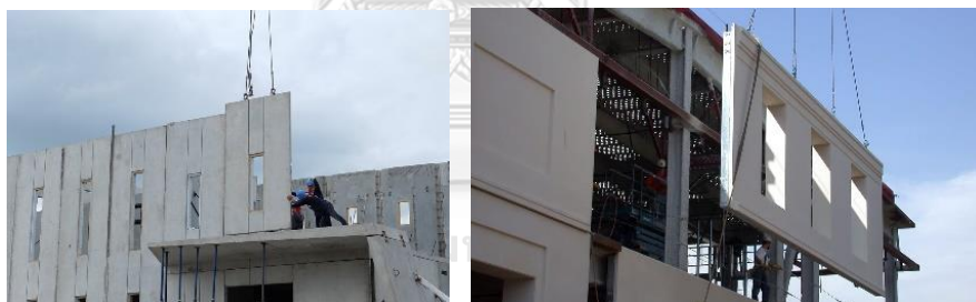
รูปภาพ 2.1 ระบบการก่อสร้างผนังสำเร็จรูป (Precast)
