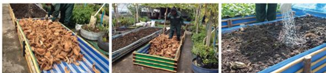
ภาพ 48 การก่อสร้างกระบะปลูกของ สวนเกษตรดาดฟ้า เขตหลักสี่
