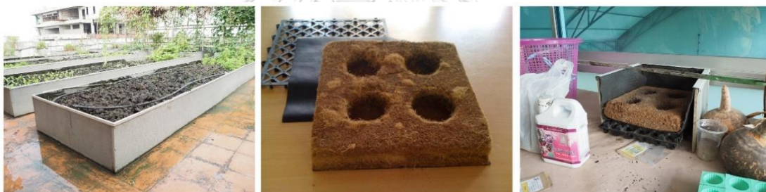
ภาพ 63 การก่อสร้างกระบะปลูก สวนเกษตรดาดฟ้า คณะสถาปัตย์ฯ ม.เกษตรฯ
