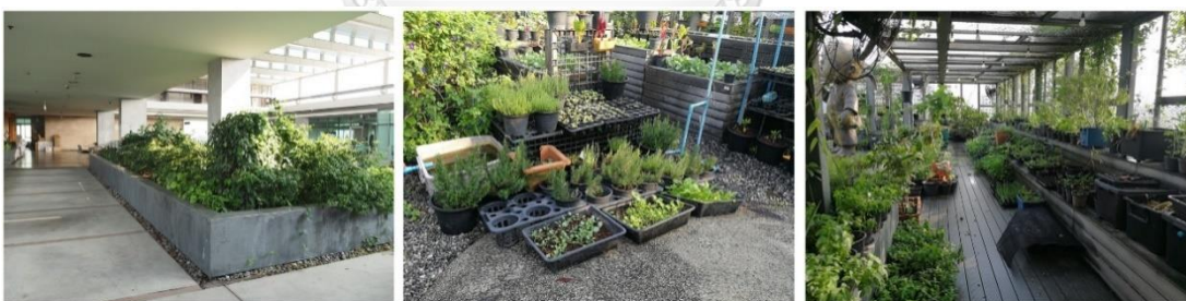
ภาพ 81 รางรับน้ำเปิดบริเวณทางเดิน พื้นระบายน้ำลาดเอียงใช้พื้นกรวด และพื้นไม้เทียม สวนเกษตรดาดฟ้า สสส.
