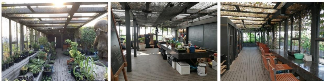
ภาพ 82 การติดตั้งไฟ บริเวณทางเดิน ห้องเรียน และบริเวณนั่งพัก สวนเกษตรดาดฟ้า สสส.
