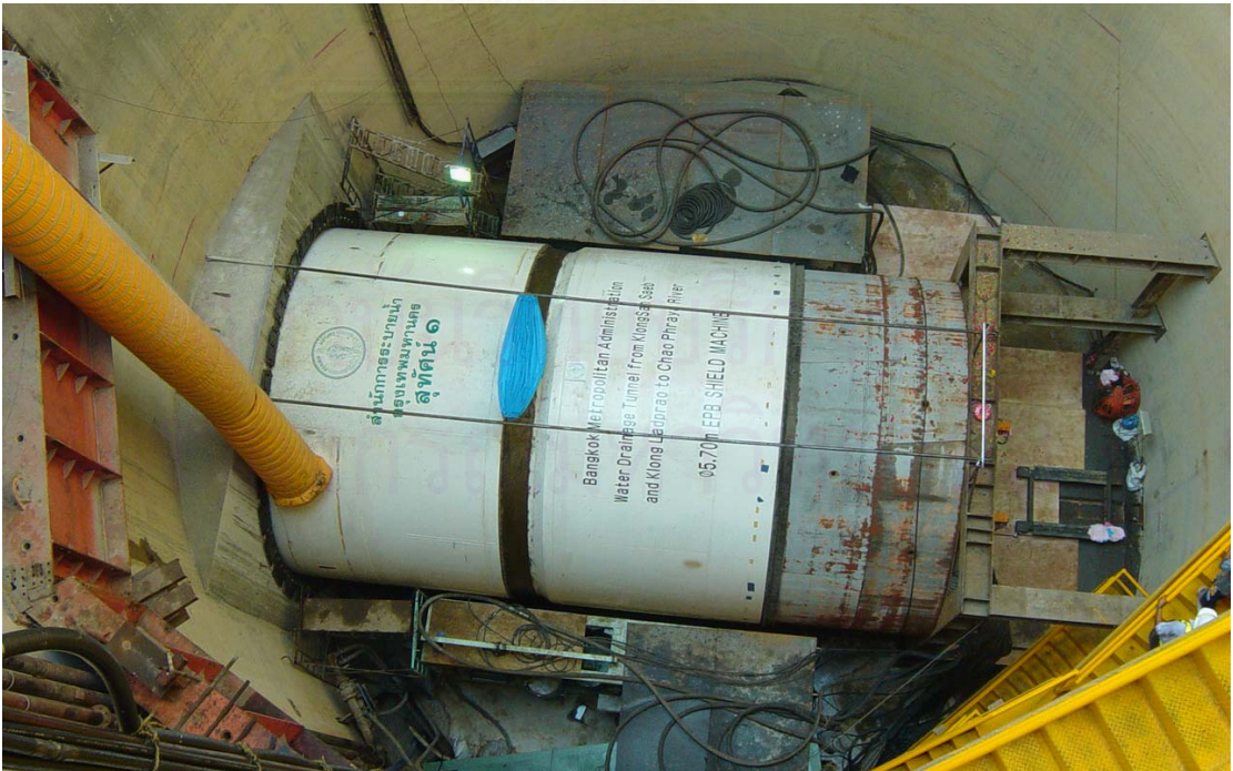
รูปที่ 3.36 การติดตั้งหัวเจาะในปล่องอุโมงค์
