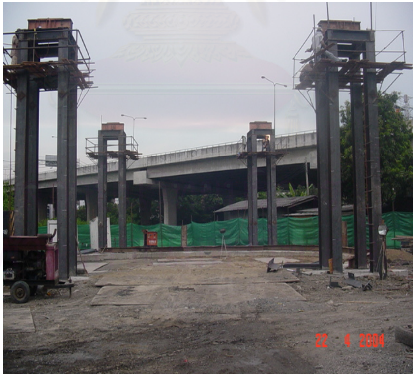
รูปที่ 3.6 การก่อสร้าง Ring beam เสร็จสมบูรณ์
