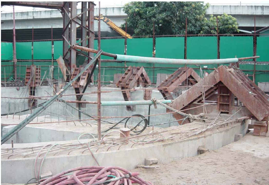
รูปที่ 3.19 การจัดวาง Stopper structure รอบปล่องอุโมงค์
