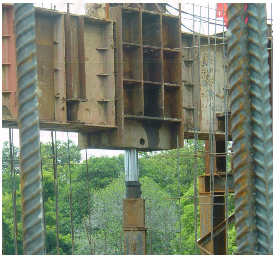
รูปที่ 3.9 แม่แรง Hydraulic jack ที่ใช้ในการกดปดองอุโมงค์
