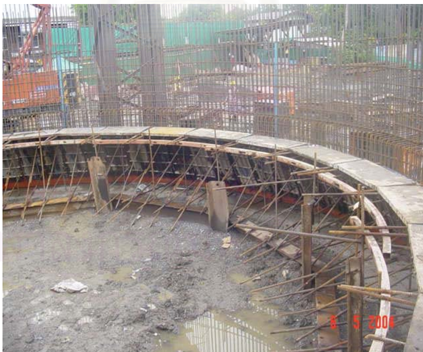
รูปที่ 3.11 การประกอบ Cutting edge
