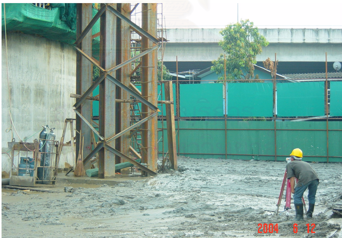
รูปที่ 3.17 การตรวจสอบแนวตั้งของปล่องอุโมงค์ในขณะจมปล่องอุโมงค์
