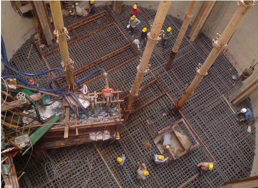
รูปที่ 3.24 การเตรียมการเท Base slab
