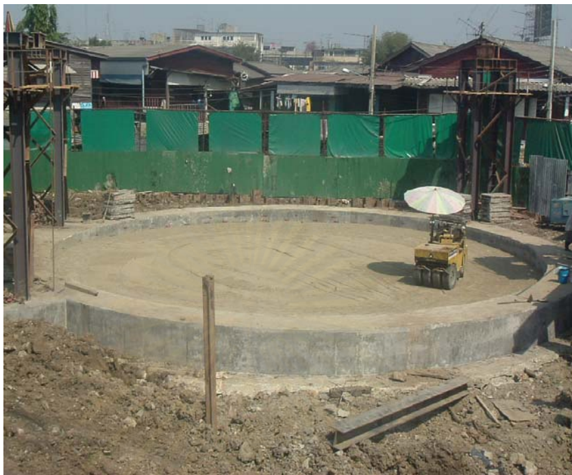
รูปที่ 3.6 การก่อสร้าง Ring beam เสร็จสมบูรณ์
