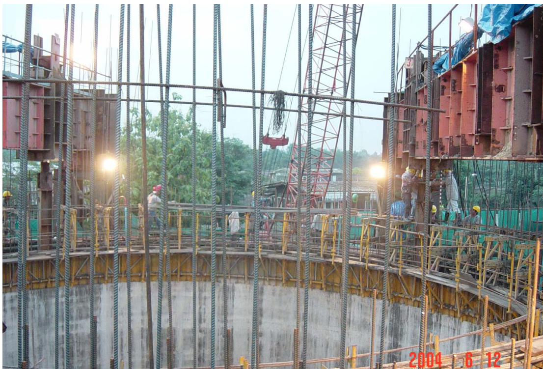
รูปที่ 3.16 การยกปล่องอุโมงค์ด้วย แม่แรง (Hydraulic jack)
