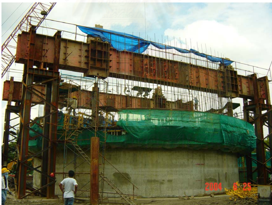
รูปที่ 3.1 ปล่องอุโมงค์ (Inlet shaft) บึงพระรามเก้า
