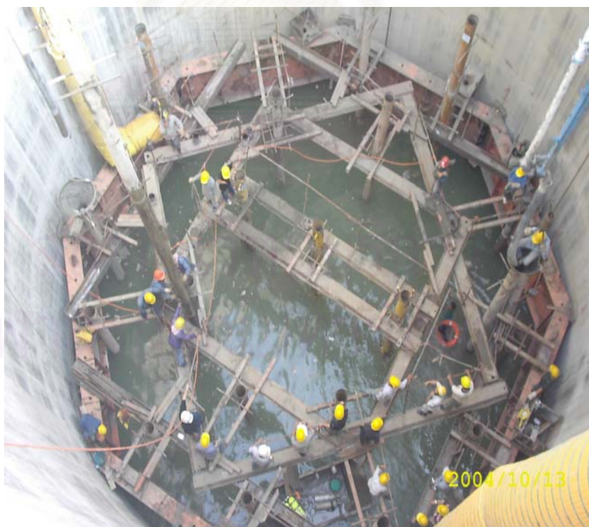
รูปที่ 3.23 การเท Concrete plug ด้วย Trimie pipe
