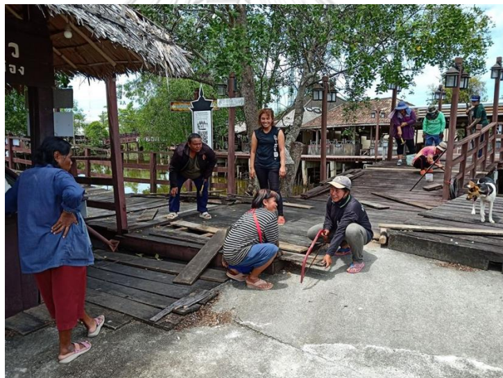
ภาพที่ 4.7 ชาวบ้านร่วมแรงร่วมใจกันก่อสร้างสะพานไม้ ชุมชนริมน้ำคลองแดน จังหวัดนครศรีธรรมราช
