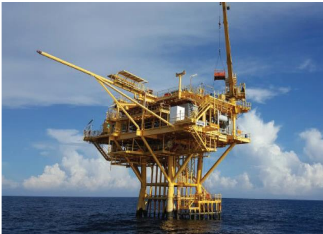
ภาพที่ 1.4 แท่นหลุมผลิต (Wellhead Platform, WHP)
