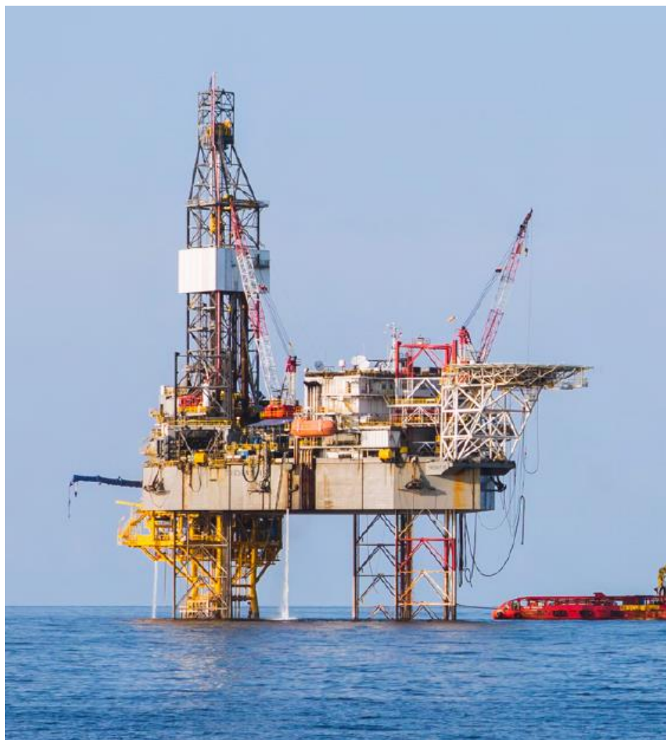
ภาพที่ 1.6 แท่นขุดเจาะชนิดขาห้อย (Jack Up Rig) ที่มา : กรมเชื้อเพลิงธรรมชาติ กระทรวงพลังงาน (2559)
