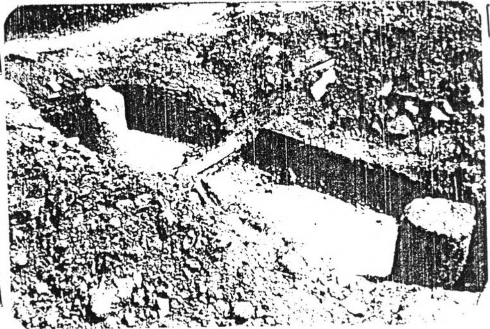
รูปที่ 4-46 ท่อร้อยสายโทรคัพท์ เป็นอุปสรรคงานฐานราก
