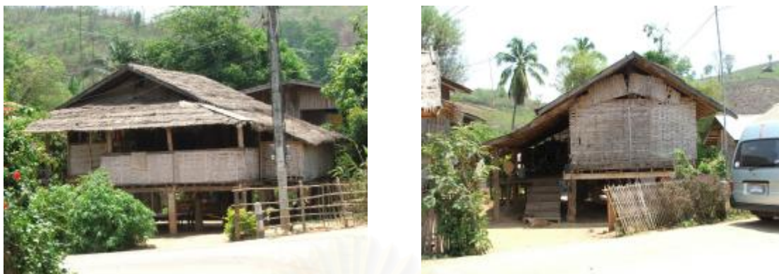
ภาพที่ 3.21-3.22 ภาพบ้านเก่าในหมู่บ้านปางสา หลังคาทำจากใบจาก และสังกะสี
