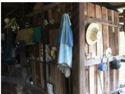
ภาพที่ 3.78-3.79 ภาพบ้านเก่าในหมู่บ้านต้นฮ้าง ฝาผนังทำจากแผ่นไม้
