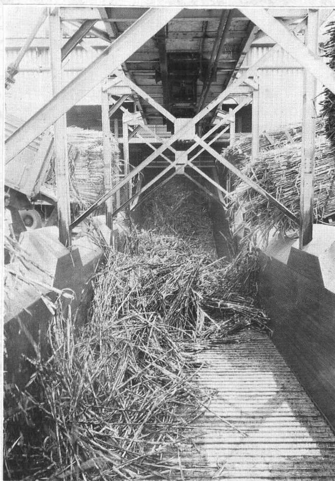
รูปที่ 2.1 ลักษณะการขนถ่ายอ้อยลงบนสะพานป้อนอ้อย
