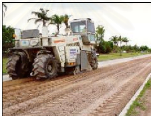
รูปที่ 2.12 ขั้นตอนการขุดหรือผิวทางขั้นแรก ที่มา : Ramanujam (2000)
