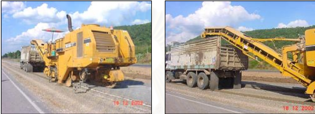
รูปที่ 3.3 การซูดรี้อชั้นทางเก่า
