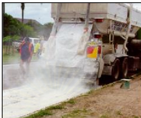
รูปที่ 2.14 การโรยผงปูนขาวลงบนหน้าผิวทางที่ถูกขูดหรือ ที่มา : Ramanujam (2000)
