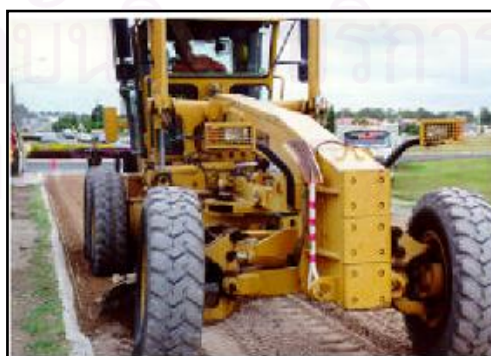
รูปที่ 2.13 ขั้นตอนการปรับระดับชั้นทาง ที่มา : Ramanujam (2000)
