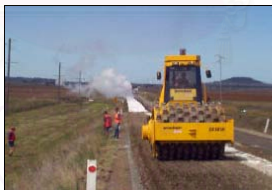
รูปที่ 2.17 การบดอัดชั้นทางที่ได้รับการปรับสภาพแล้ว ที่มา : Kendall et al (2000)
