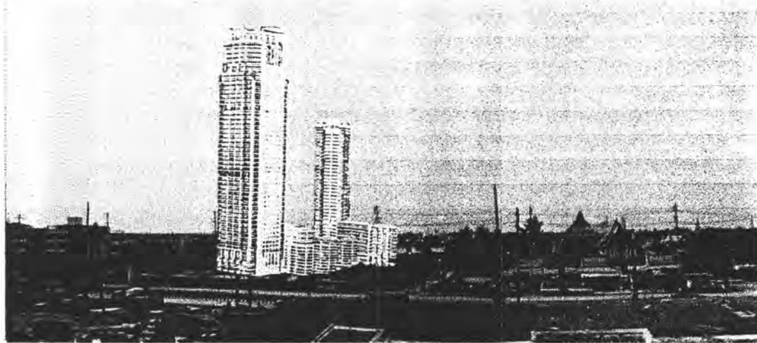
ภาพที่ 2.4 ภาพที่ใช้ในการประเมินโครงการอาคารสำนักงานใหญ่ ธนาคารกรุงไทย จำกัด (มหาชน) และอาคารพักอาศัย จังหวัดกรุงเทพฯ
