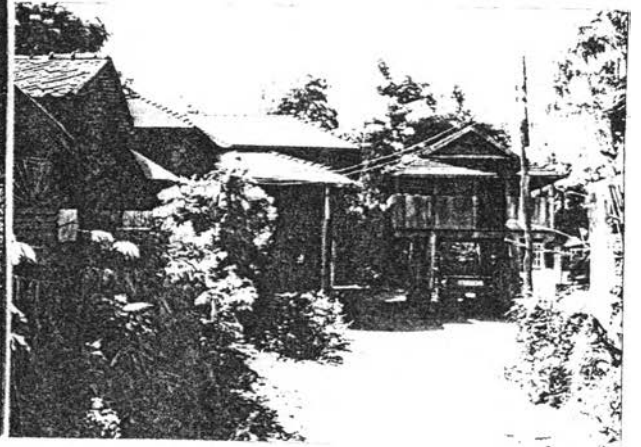
- ลักษณะการใช้ไฟฟ้า เข้าสู่บ้านพักอาศัย
