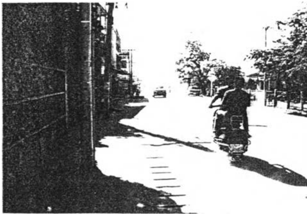
ระบบท่อระบายมีขนาดเล็ก
