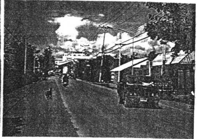
- ลักษณะโครงข่ายไฟฟ้า สายรอง
