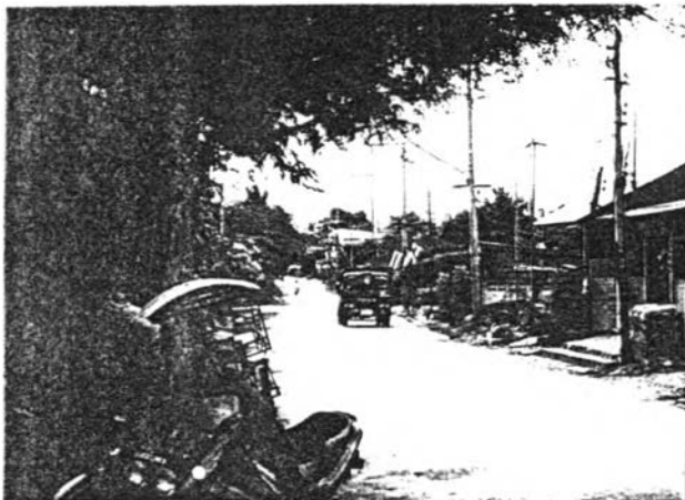
ลักษณะ โครงข่ายไฟฟ้าสายรอง
