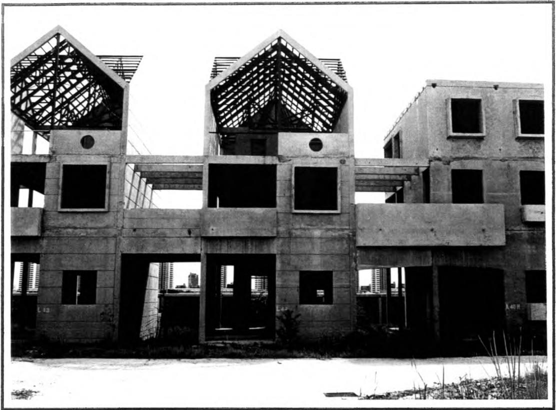
รูปที่ ง.1 อาคาร โครงการ ก ที่ก่อสร้างด้วยระบบสำเร็จรูป
