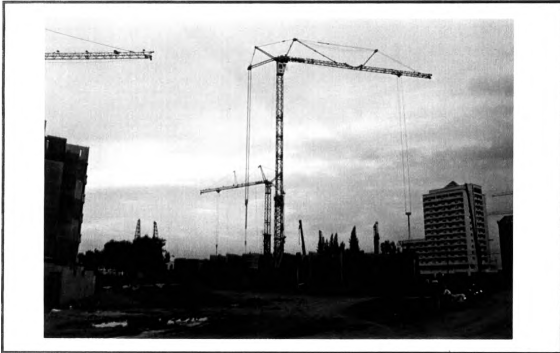
รูปที่ จ.1 ทาวเวอร์เครนที่ใช้เป็นเครื่องจักรสำหรับยกชิ้นส่วนสำเร็จรูป
