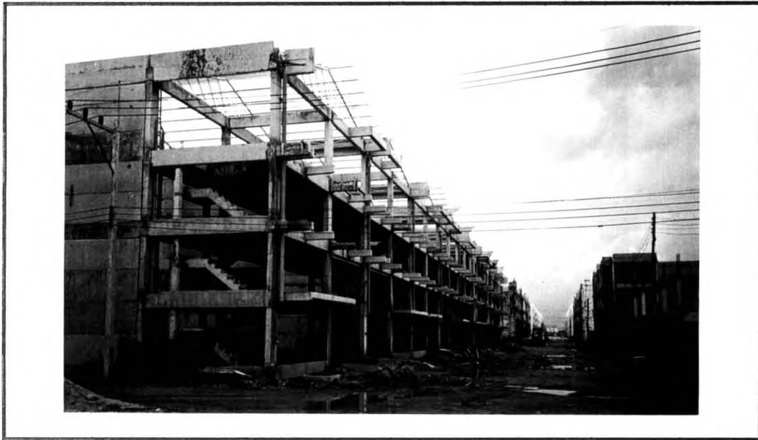
รูปที่ ง.4 อาคารโครงการ ค ที่ก่อสร้างด้วยระบบสำเร็จรูป
