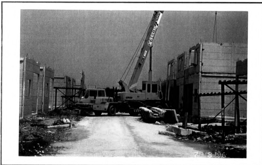
รูปที่ จ.2 รถโมบายเครนที่ใช้เป็นเครื่องจักรสำหรับยกชิ้นส่วนสำเร็จรูป
