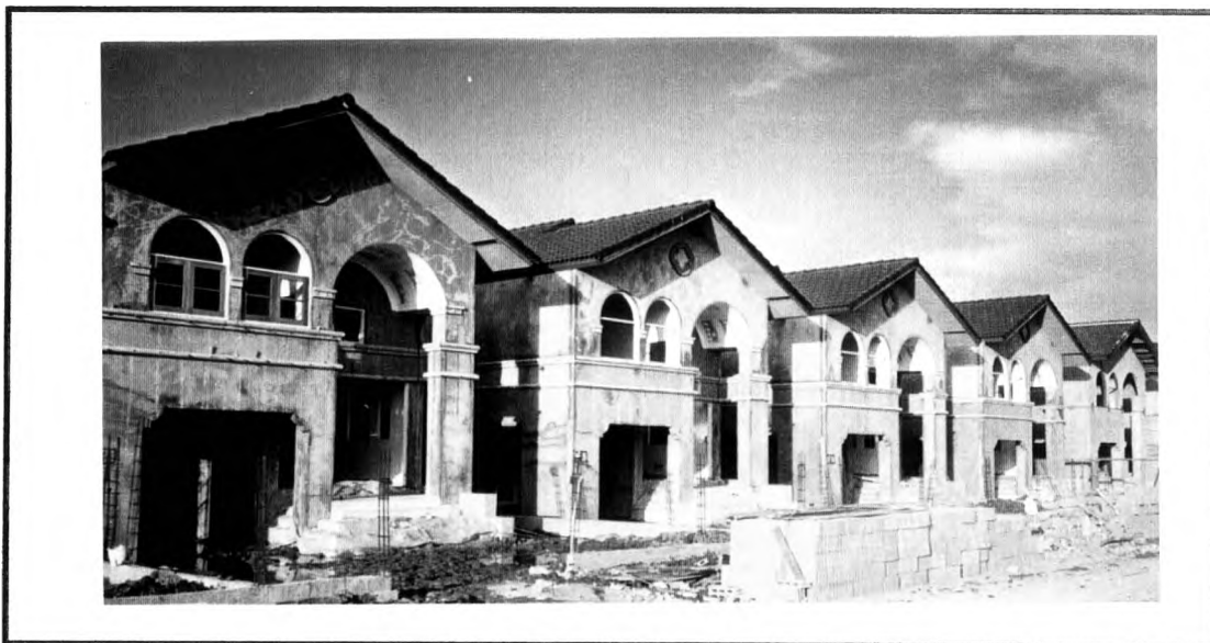
รูปที่ ง.2 อาคารโครงการ ข ที่ก่อสร้างด้วยระบบสำเร็จรูป
