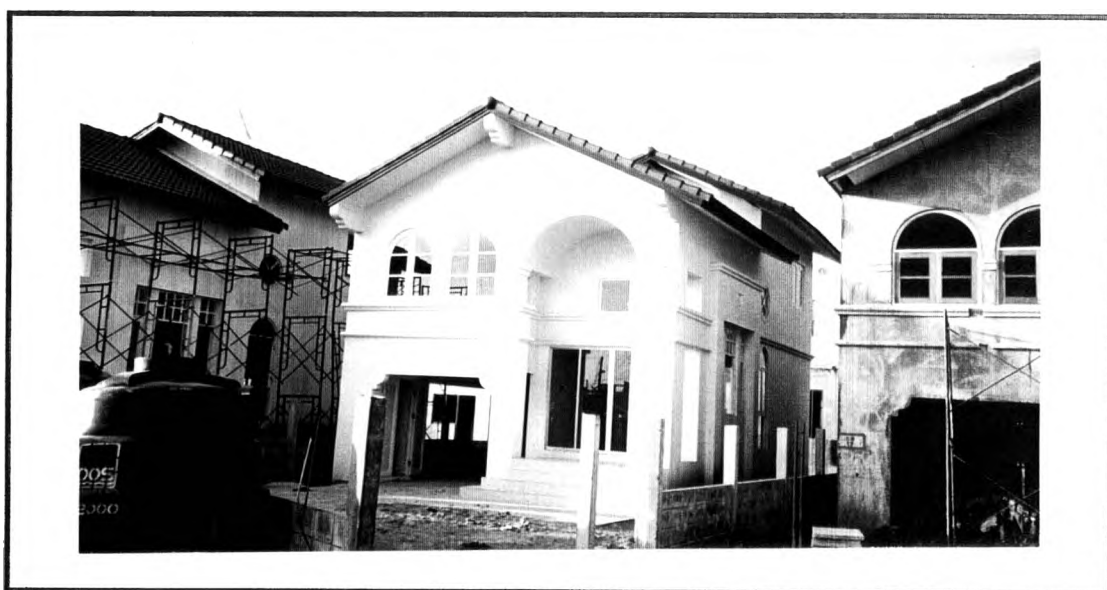
รูปที่ ง.2 อาคารโครงการ ข ที่ทำงานสถาปัตยกรรมเสร็จแล้ว
