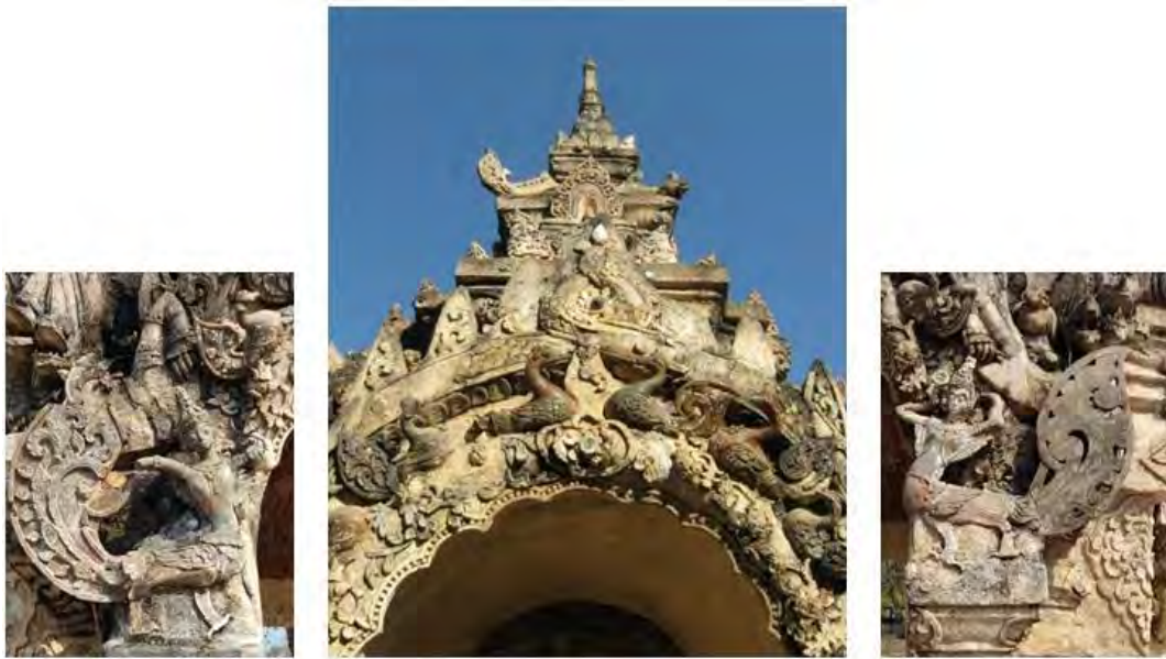
ภาพที่ ๓.๑๑ การประดับรูปกนิษฐีและชั้นหลังคาซุ้มโขงด้วยรูปสัตว์ที่ทำด้วยเครื่องเคลือบดินเผา
