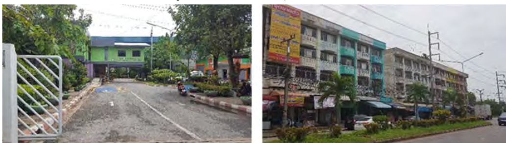
รูปที่ 43 สำนักงานนิคมอุตสาหกรรม (ซ้าย) และตัวอย่างพื้นที่พาณิชยกรรม (ขวา)
