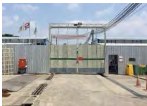
ภาพที่ 25 ทางเข้าที่พักแรงงานก่อสร้าง
