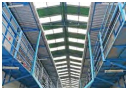
ภาพที่ 29 แนวท่อระบายน้ำฝน
