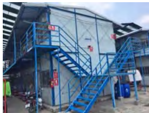
ภาพที่ 33 บันไดทางขึ้นอาคารชั้นสอง
