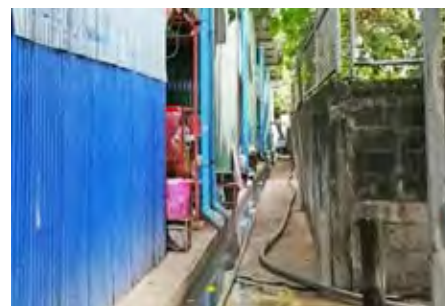
ภาพที่ 30 แนวท่อระบายน้ำ
