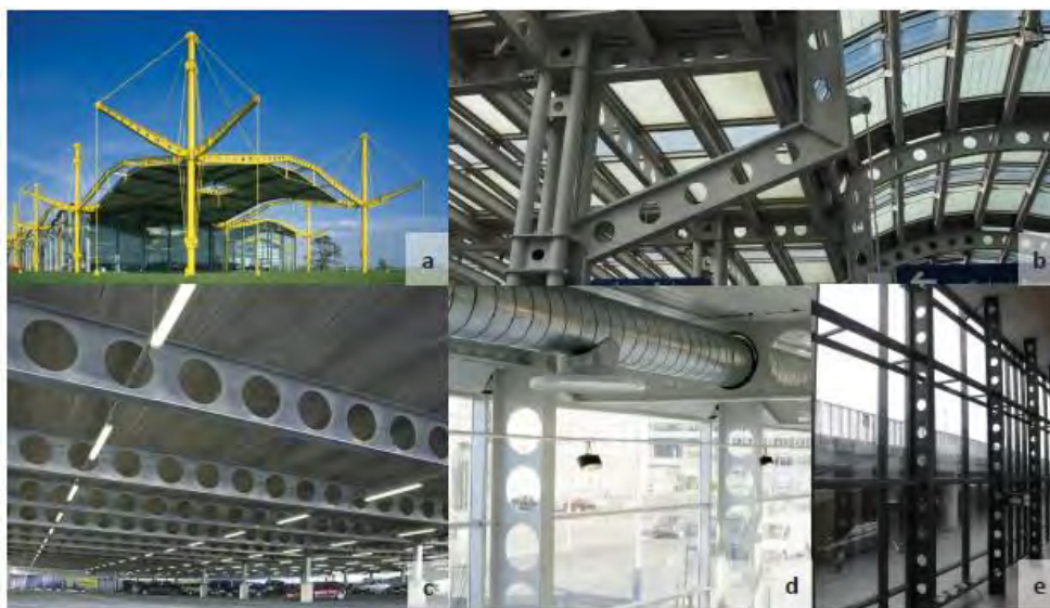
ภาพที่ 1.2 ตัวอย่างการใช้องค์อาคารเซลลูลาร์ (a) Renault distribution centre (Swindon, UK), (b) Chicago O'Hare Airport (USA), (c) Ikea car park (Leeds, UK), (d) Porsche garage (Liverpool, UK), (e) supermarket (Reykjavik, Iceland). [2]
