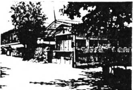
อาคารที่มีการปรับปรุงก่อสร้างเพิ่มเติมเพื่อบรรจุพื้นที่ภายในมาพัก
