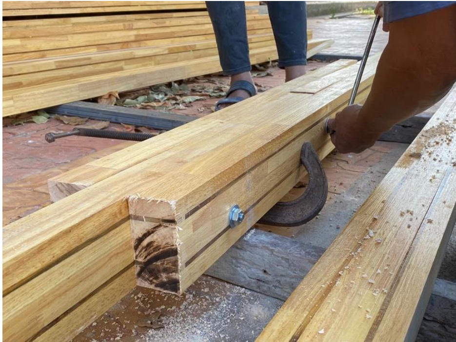
ภาพที่ 81 แสดงขั้นตอนการประกอบตงพื้น
