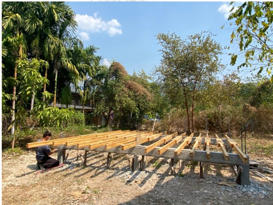
ภาพที่ 82 แสดงการวางตงพื้นบนคานคอนกรีตเสริมเหล็ก
