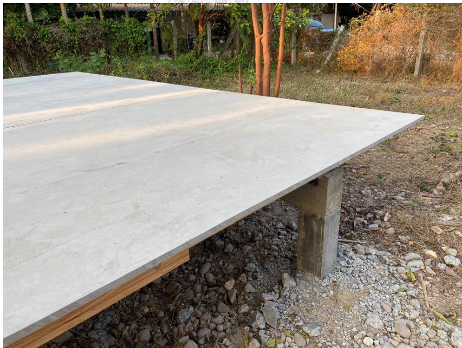
ภาพที่ 84 แสดงการติดตั้งแผ่นพื้นความหนา 20 มิลลิเมตร
