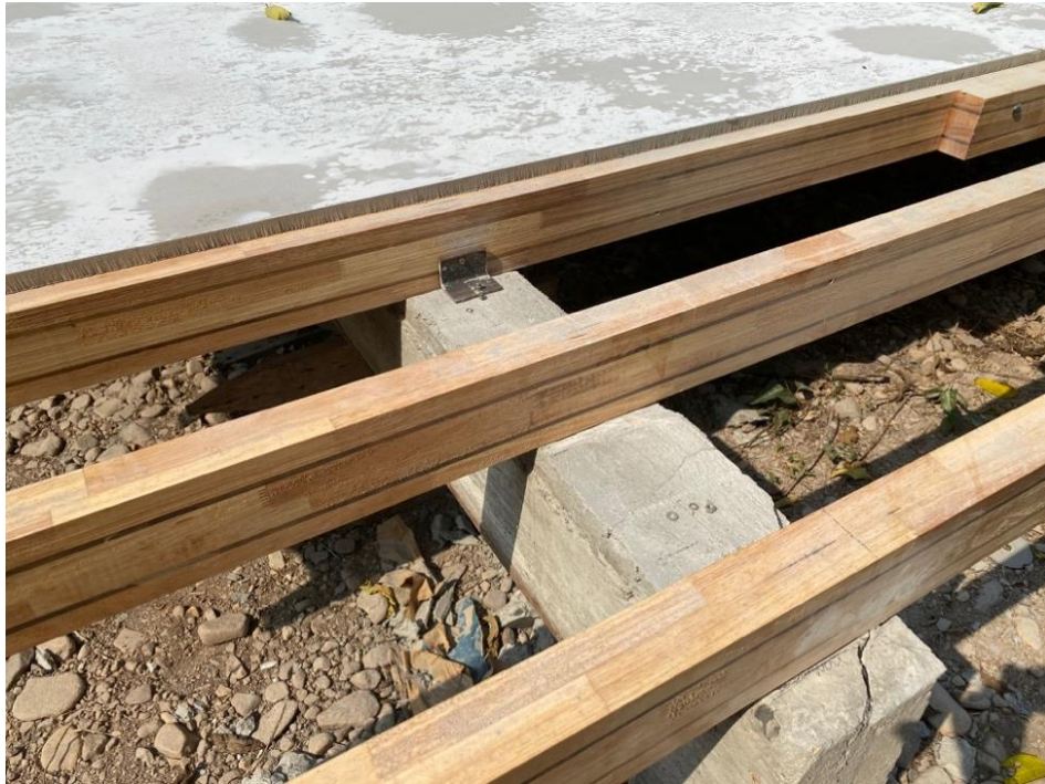
ภาพที่ 83 แสดงการยึดตั้งพื้นด้วยเหล็กฉากกับคานคอนกรีตเสริมเหล็ก
