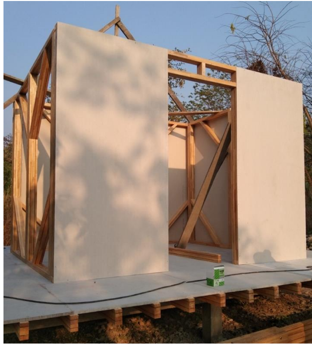
ภาพที่ 86 แสดงแผ่นเรียบสำหรับติดตั้งกับโครงคร่าวผนัง
