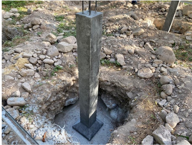
ภาพที่ 79 แสดงเสาสำเร็จขนาดหน้าตัด 6 นิ้ว
