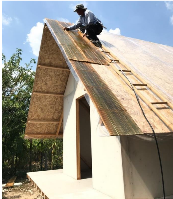
ภาพที่ 94 แสดงขั้นตอนการติดตั้งฟากหลังคาไม้ไผ่
