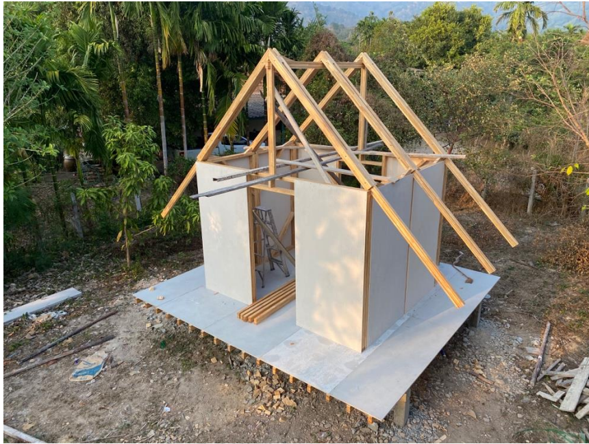
ภาพที่ 88 แสดงการวางจันทันหลังคา
