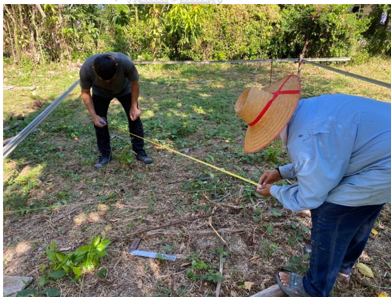
ภาพที่ 78 แสดงขั้นตอนการจับระดับระยะของแนวเสา และคาน
