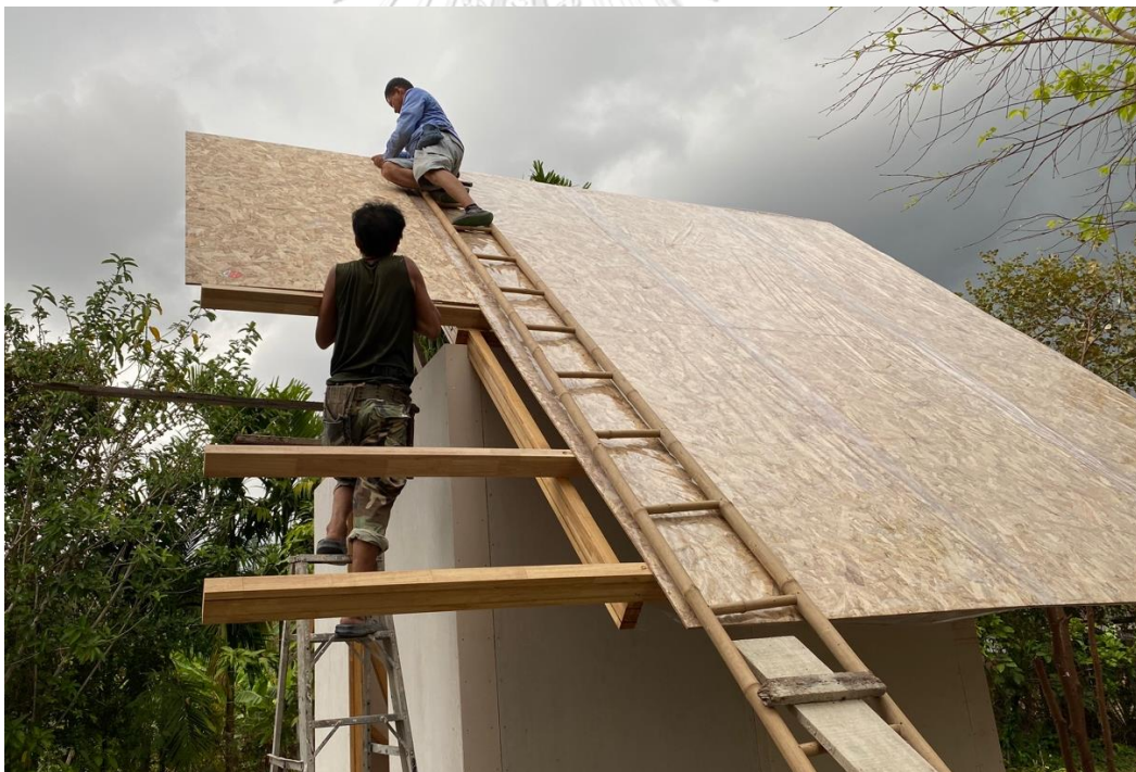
ภาพที่ 91 แสดงการติดตั้งแผ่นไม้เรียงชั้น และพลาสติกกันน้ำ
