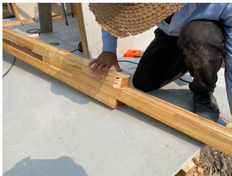
ภาพที่ 87 แสดงการบากจันทันหลังคาเพื่อวางบนโครงสร้างผนัง
