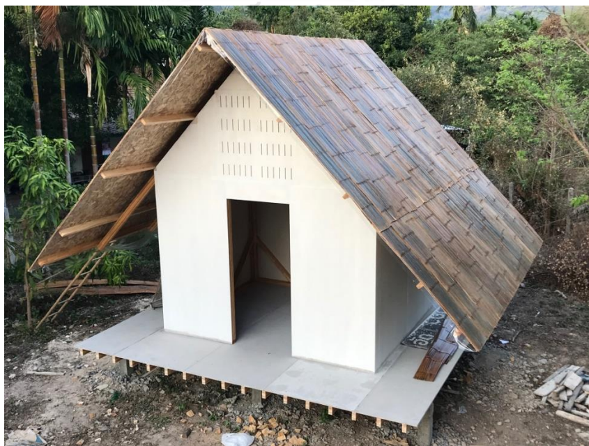
ภาพที่ 95 แสดงอาคารหลังจากติดตั้งฟากไม้ไผ่
