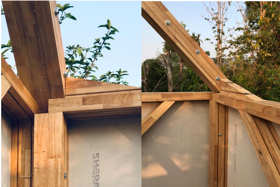
ภาพที่ 90 แสดงการวางจันทันบนโครงสร้างผนัง
