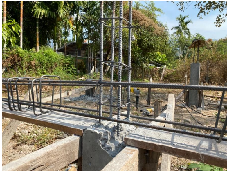
ภาพที่ 80 แสดงขั้นตอนการผูกเหล็กหล่อคาน
