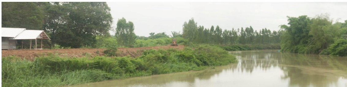
ภาพที่ 59 รูปถ่ายถนนที่กำลังสร้างเพื่อกั้นน้ำจากแม่น้ำยมทางฝั่งขวาไม่ให้หลากเข้ามาท่วมในพื้นที่นาข้าว ที่มา: ถ่ายเมื่อวันที่ 9 กรกฎาคม 2562
