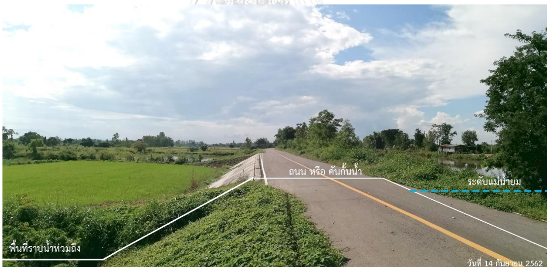
ภาพที่ 58 รูปถ่ายถนนที่กั้นน้ำจากแม่น้ำยมทางฝั่งขวาไม่ให้ไหลเข้ามาท่วมในพื้นที่นาข้าว ที่มา: ถ่ายเมื่อวันที่ 14 กันยายน 2562
