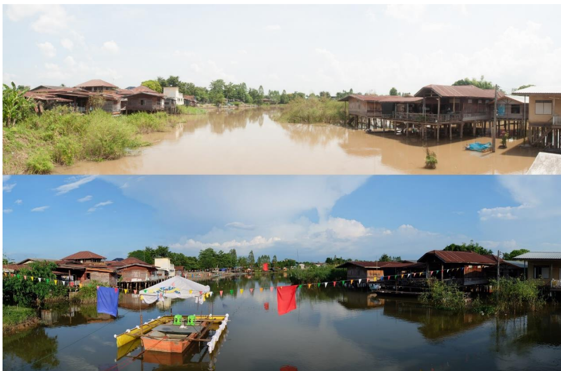
ภาพที่ 50 รูปถ่ายชุมชนบ้านกริมแม่น้ำ และเกาะกลางแม่น้ำยมของตำบลกงช่วงฤดูน้ำหลาก ปี 2561 และ 2562 ที่มา: จากการลงสำรวจในปี พ.ศ. 2561 และ พ.ศ. 2562
