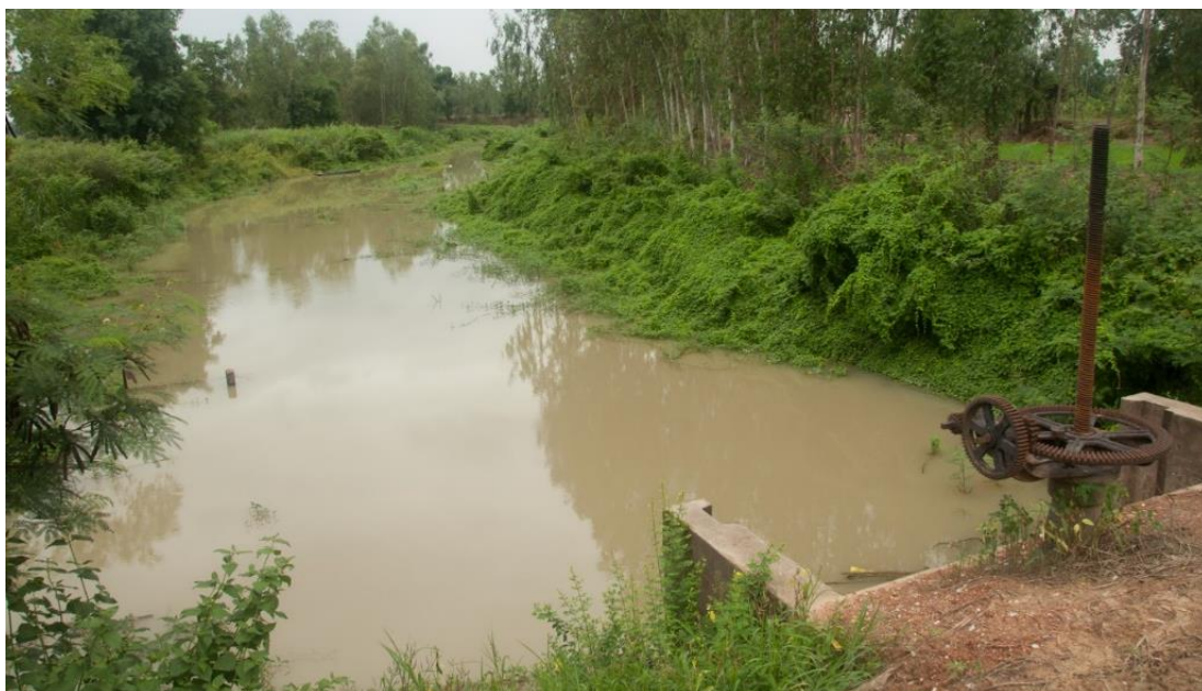
ภาพที่ 61 รูปถ่ายปากท่อระบายน้ำที่กั้นคลองลู่ (ลำน้ำสาขา) กับแม่น้ำยม ที่มา: ถ่ายเมื่อวันที่ 14 กันยายน 2562
