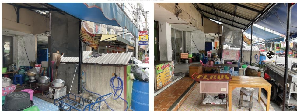
ภาพที่ 5.52 สภาพการต่อเติมร้านขายอาหารบริเวณพื้นที่จอดรถและทางเดิน ชัยมงคลแมนชั่น
