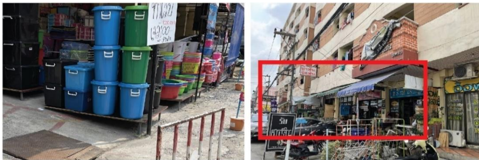
ภาพที่ 5.28 การต่อเติมหลังคาและพื้นสำหรับร้านค้าอพาร์ทเมนต์ แกรนด์ แมนชั่น
