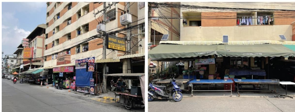
ภาพที่ 5.25 การต่อเติม, ตั้งร้านค้าด้านหน้าอพาร์ทเมนต์ แกรนด์ แมนชั่น
