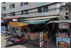
การต่อเติมหลังคาด้านหน้า ภาณีแมนชั่น (2.67)
