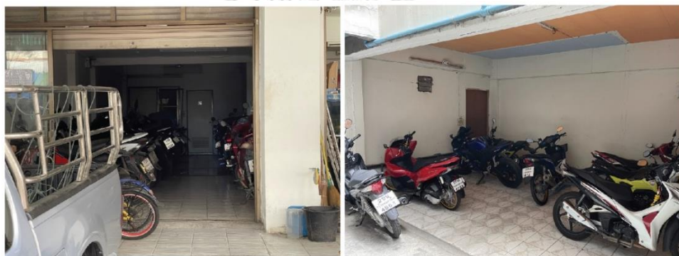
ภาพที่ 5.49 พื้นที่ต่อเติมสำหรับจอดรถจักรยานยนต์ อพาร์ทเมนต์ ชัยมงคล แมนชั่น
