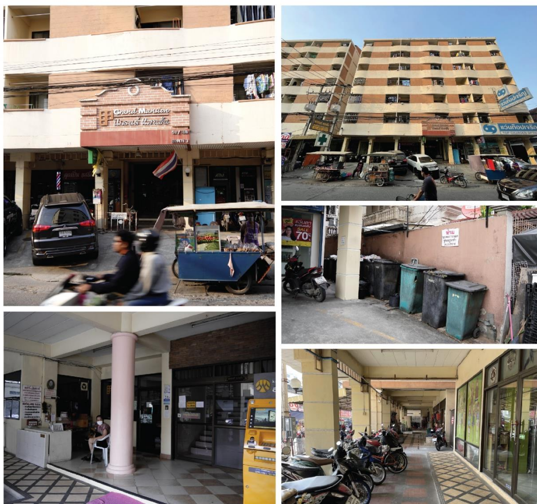
ภาพที่ 5.4 สภาพภายนอก, ทางเดินภายใน โถงทางเข้า และพื้นที่ทิ้งขยะ แกรนด์แมนชั่น
