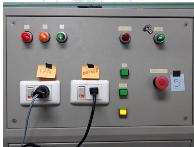
รูปที่ 4.30 แผงควบคุมระบบไฮดรอลิก
