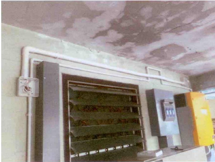
รูปที่ 3-2 การติดตั้งอินเวอร์เตอร์
