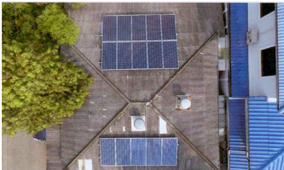
รูปที่ 3-1 การติดตั้งแผงเซลล์แสงอาทิตย์จำนวน 15 แผง
