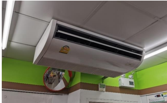
รูปที่ 4.21 รูปถ่ายลักษณะของคอยล์เย็น หรือ Indoor Unit ภายในร้านสะดวกซื้อ
