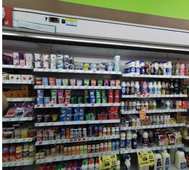
รูปที่ ค.20 ตู้เย็นแบบประตูเปิด สำหรับแช่โยเกิร์ต (ชุดที่ 7)
