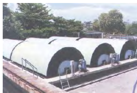
รูปที่ 2.12 แสดงระบบบำบัดน้ำเสียแบบแผ่นหมุนชีวภาพ ( www.pcd.go.th )
