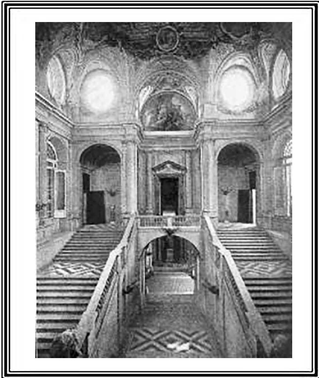
ESCALERA PRINCIPAL DEL PALACIO REAL (MADRID)
