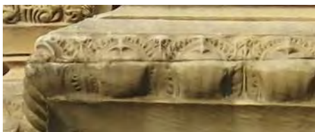
รูปภาพที่ 401 ลายบัวหงายประดับประดับโคนเสาบริเวณห้องครรภคฤหะของปราสาทพิมาย (ที่มา: ผู้วิจัย)
