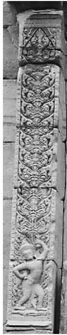
รูปภาพที่ 268 เสาคัตติผนังบริเวณประตูทางเข้า ปราสาทประธานฝั่งทิศใต้
