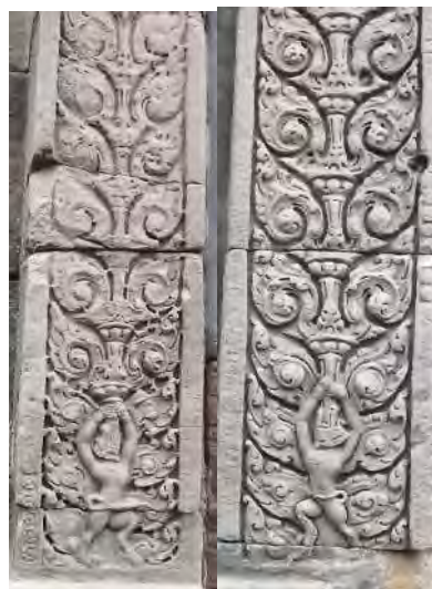
รูปภาพที่ 335 รายละเอียดเสาดัดผนังประตูทางเข้าปราสาทประธานฝั่งทิศตะวันออก
