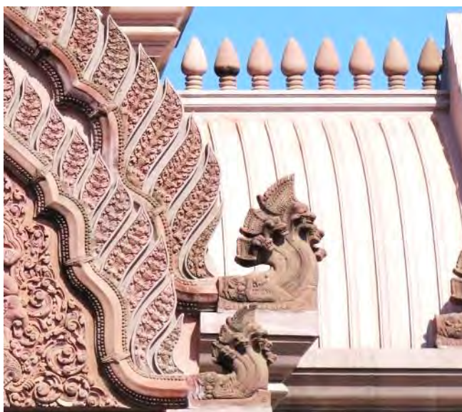
รูปภาพที่ 692 หลังคาประดับบราลีที่มีลักษณะคล้ายดอกบัวตูม
