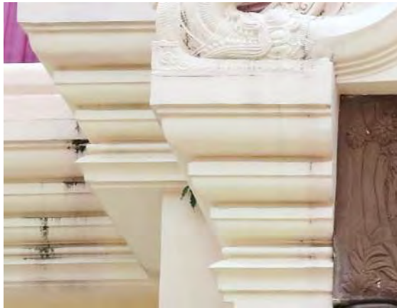
รูปภาพที่ 777 ลวดบัวซ้อนชั้นหัวเสาไม่ได้มีการประดับตกแต่งลวดลายใดๆ (ที่มา: ผู้วิจัย)
