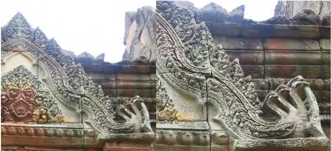
รูปภาพที่ 168 กรอบซุ้มภายในประดับลายก้านต่อดอกคั่นด้วยดอกประจำยาม ปลายซุ้มประดับพญานาค 5 เศียร คายอุบะบริเวณประตูฝั่งซ้ายของระเบียงคดชั้นนอกทางทิศตะวันออก
