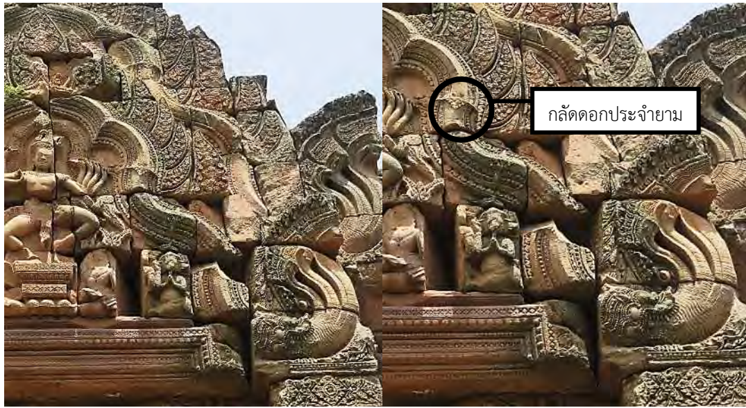
รูปภาพที่ 201 กรอบซุ้มหน้าบันประตูทางเข้ามณฑปทางทิศตะวันออกไม่มีการตกแต่งลวดลายภายใน มีเพียงการกลัดดอกประจำยามและการตกแต่งขอบกระหนกเล็ก 2-3 ชั้น ปลายซุ้มประดับมกรคาย พญานาคทรงเครื่อง 5 เศียร
