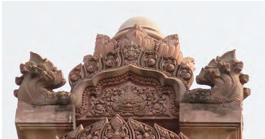
รูปภาพที่ 750 บริเวณส่วนยอดของหลังคา หอประดิษฐานพระพุทธรูป โรงเรียนไพศาลพิทยาคม จ.บุรีรัมย์ (ที่มา: ผู้วิจัย)
