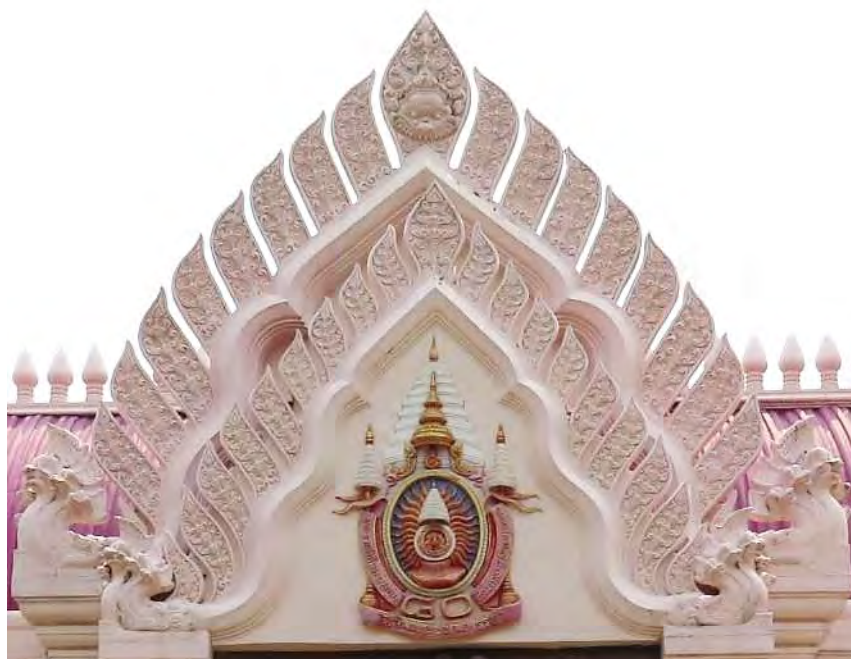
รูปภาพที่ 768 หน้าบนชั้นที่ 1 ทางฝั่งทิศเหนือ อาคารอนุสรณ์สถานการเสด็จราชดำเนิน วัดอินทบูรพา จ.บุรีรัมย์ (ที่มา: ผู้วิจัย)
