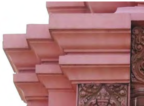
รูปภาพที่ 746 หัวเสาประดับลวดบัวซ้อนชั้นมีได้ประดับตกแต่งลวดลายใดๆ (ที่มา: ผู้วิจัย)
