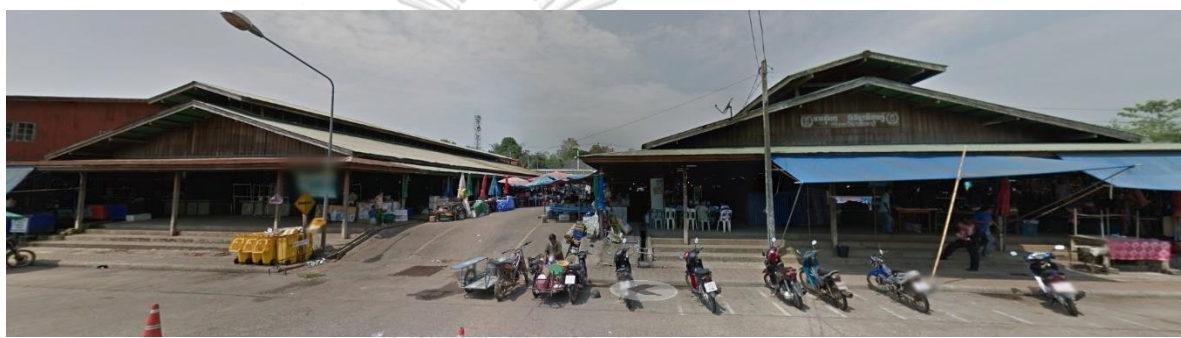
ภาพ 52 ภาพด้านหน้าอาคารตลาดเทศบาล ที่มา: Google maps, 2556
