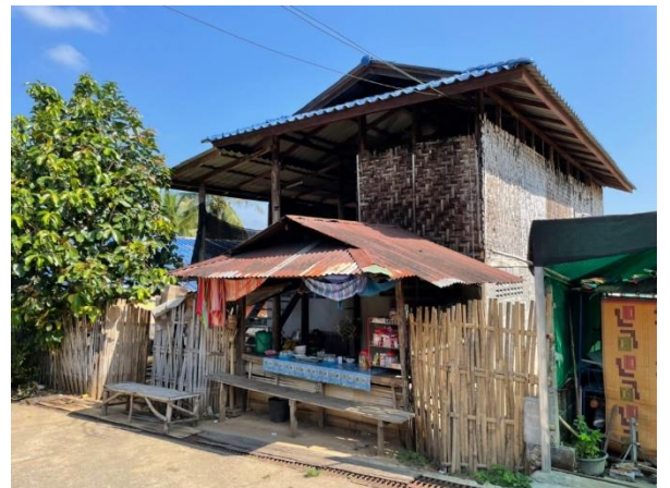
ภาพ 47 ที่พักอาศัยซึ่งต่อเติมพื้นที่ด้านหน้าเป็นร้านค้า ที่มา: ผู้วิจัย, 2562
