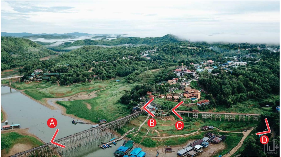
ภาพ 97 ทศนิยมภาพมุมสูงบริเวณสะพานมอญและสะพานแดง แสดงการเชื่อมต่อกันระหว่างพื้นที่แต่ละชุมชน. ที่มา: ดัดแปลงโดยผู้วิจัย, 2564 ( https://paikondieow.com/wp-content/uploads/2020/07/16-7.jpg )
