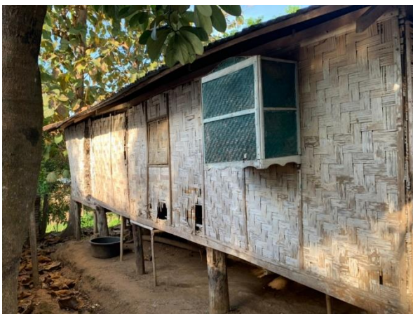
ภาพ 46 หิ้งพระที่ยื่นตัวออกจากอาคารที่พักอาศัย ที่มา: ผู้วิจัย, 2562
