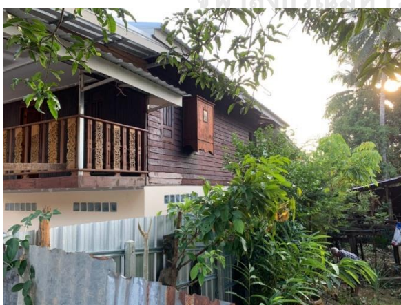
ภาพ 73 ลักษณะอาคารพักอาศัยสูง 2 ชั้นที่ใช้รูปแบบผนังแบบผสม ระหว่างไม้เนื้อแข็งและคอนกรีตสำเร็จรูป ที่มา: ผู้วิจัย, 2562
